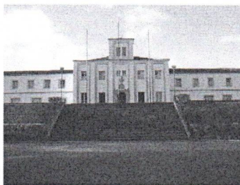
Foto 7.1 – Vista da Entrada do Centro Dom Bosco. Escadaria e fachada principal. Fonte: Inaiana Barbosa Guerra Colégio Dom Bosco - Cachoeira do Campo, fevereiro de 2007.
