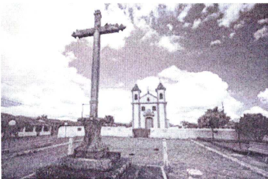
Figura 22: Capela de Nossa Senhora dos Prazeres
