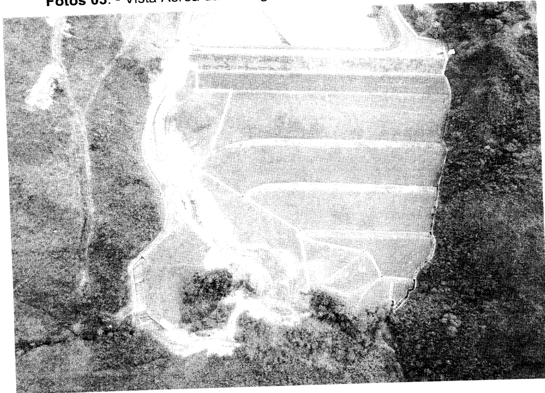
Fotos 03: - Vista Aérea da Barragem e do local de implantação da obra
