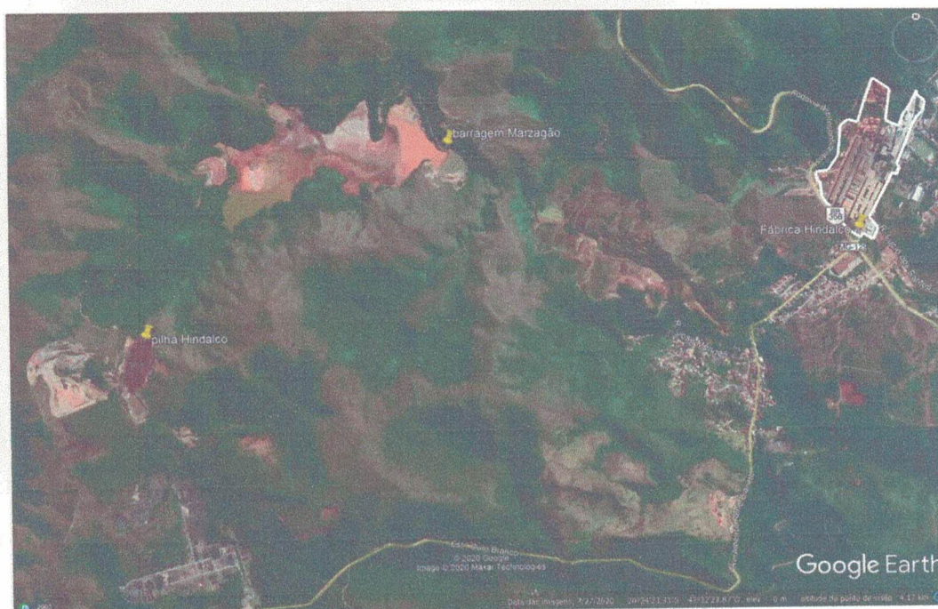
Figura 3 – Imagem contextualizando a fábrica, barragem Marzagão e pilhas de disposição do rejeito do processo Bayer.
