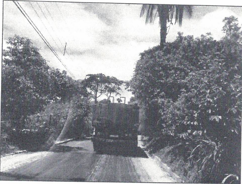
Umidificação realizada pelo Pedreira Irmãos Machado Ltda. Na Rua Ponte de Pedra.
