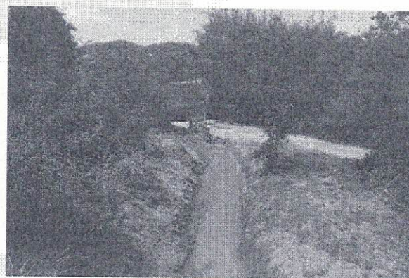
Foto 10. Bacia de contenção de sedimentos, próxima ao ponto de captação no Rio Maracujá.
