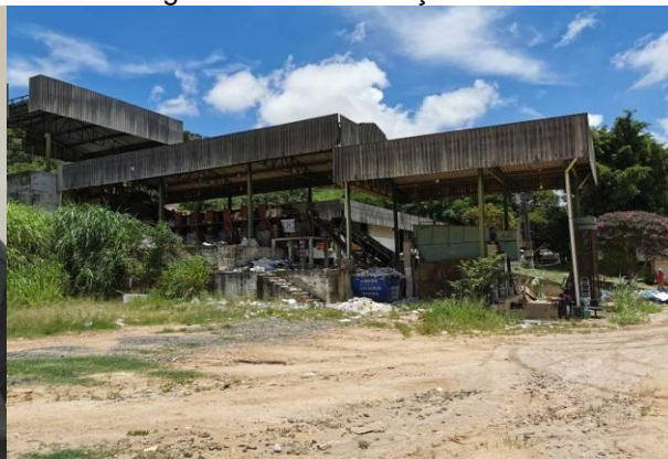
Figura 4 – Área do Aterro Sanitário.
