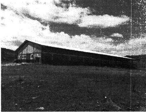
Foto 01: Vista parcial do galpão
