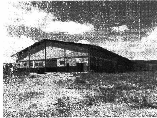
Foto 02: Vista da fachada principal
