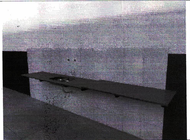
Foto 08: Vista parcial de local onde existe uma pia com bancada
