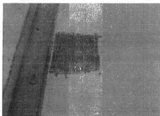
Figura 237 : Detalhe prospecção parede do nicho
