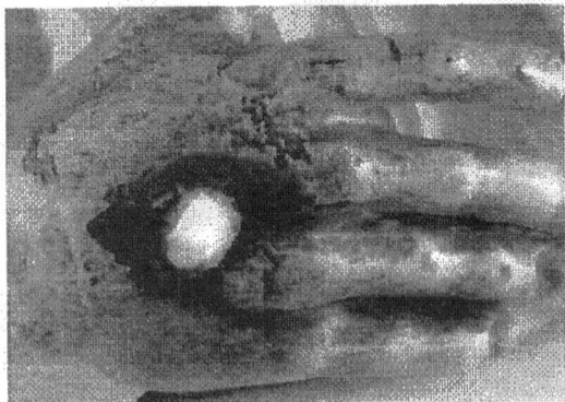
Figura 515 : Detalhe acúmulo de sujeiras Foto: ARAÚJO, Júnia. 01/07/2014.
