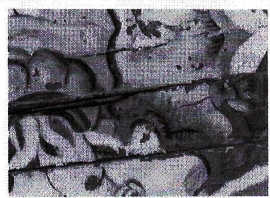
Figura 117: Ruptura de suporte Foto: ARAÚJO, Júnia. 01/07/2014.
