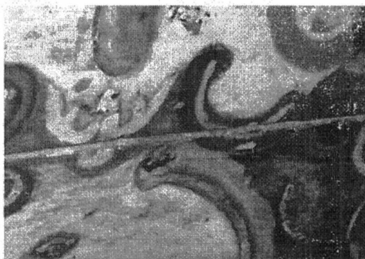
Figura 436 : Detalhe greta na junção de blocos
