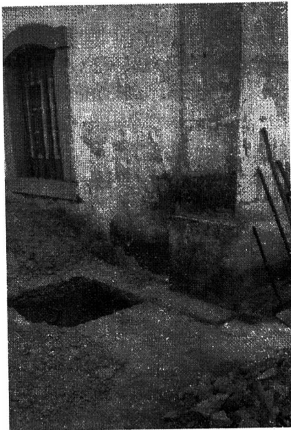
Figura 1-2 - Prospecção no terreno para verificação da fundação. Localizado na parte externa, atrás da sacristia.
