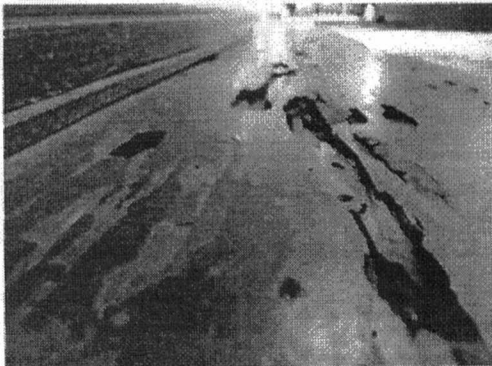
Figura 379 :Detalhe galerias superficiais Foto: ARAÚJO, Júnia. 01/07/2014.
