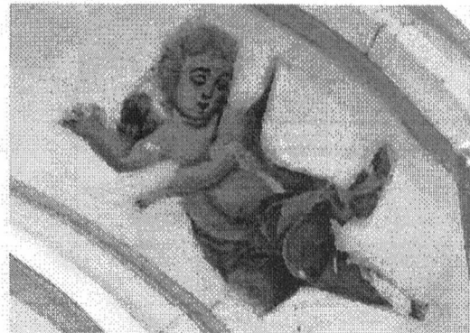
Figura 208: Pintura original com desprendimento e lacunas Foto: ARAÚJO, Júnia. 01/07/2014.
