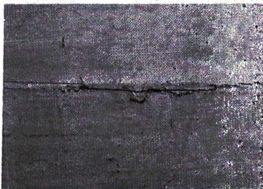
Figura 188: Detalhe da junção dos blocos
