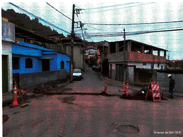
IMAGEM 03: OBRAS DE INTERLIGAÇÃO DE REDE PARA GARANTIA DO ABASTECIMENTO DAS RESIDÊNCIAS ATENDIDAS PELO RESERVATÓRIO DA RUA JOSÉ ANASTÁCIO, BAIRRO PIEDADE (14/10/2021)
