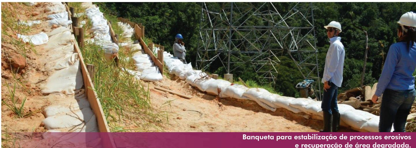
Banqueta para estabilização de processos erosivos e recuperação de área degradada.
