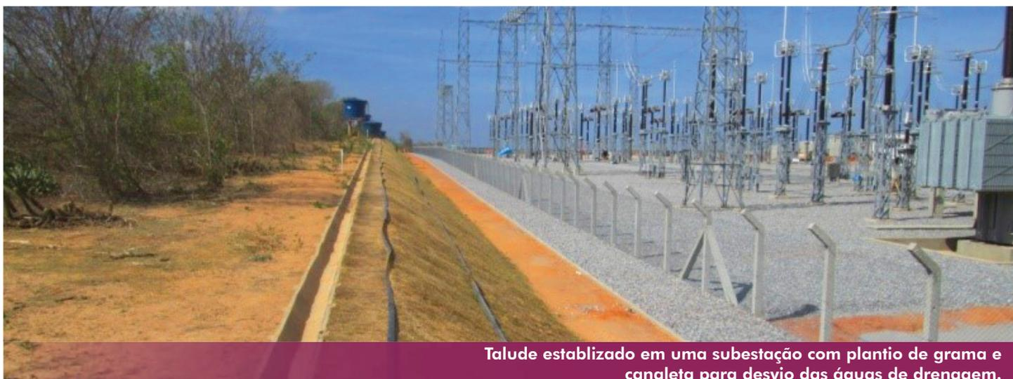
Talude estabilizado em uma subestação com plantio de grama e canaleta para desvio das águas de drenagem.
