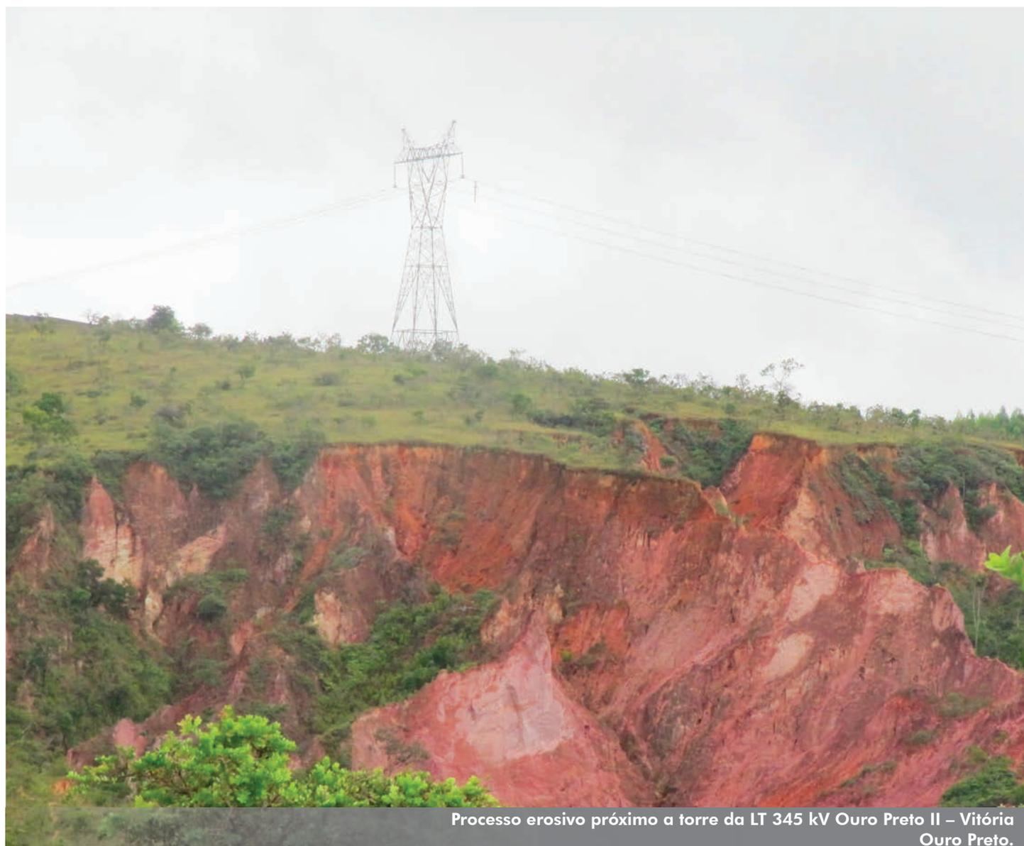
Processo erosivo próximo a torre da LT 345 kV Ouro Preto II – Vitória
