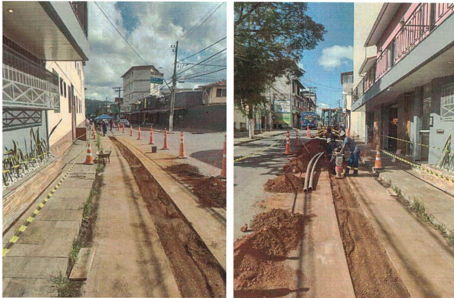
ÍNICIO OBRAS DE REDE DE ÁGUA, RUA PROF. PAULO MAGALHÃES GOMES, MORRO DO CRUZEIRO (18/04/2022)
