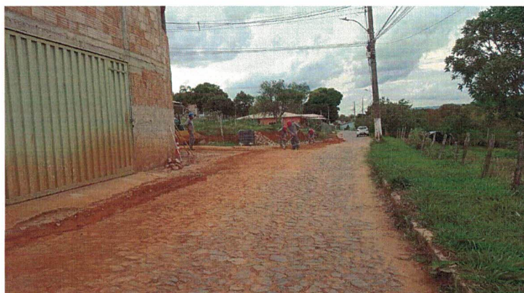
OBRAS DE REMANEJAMENTO DE REDE DE ÁGUA, RUA SANTA CRUZ, 351, GLAURA (OUT/2021)
