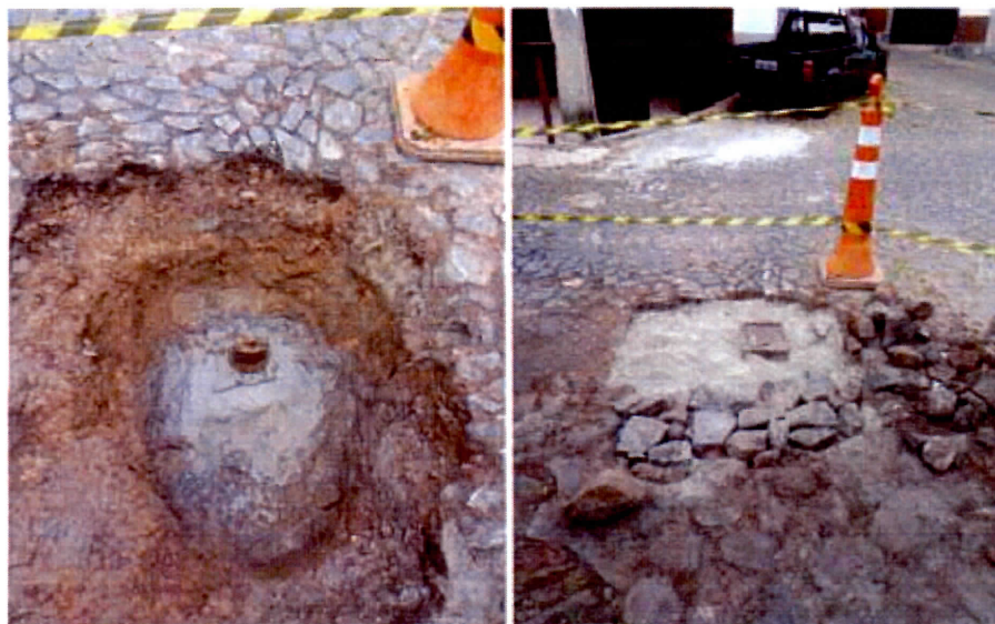
REPARO REDE DE ÁGUA, RUA DR. ORLANDO RAMOS, 120, BAIRRO VILA SÃO JOSÉ (13/05/2022)
