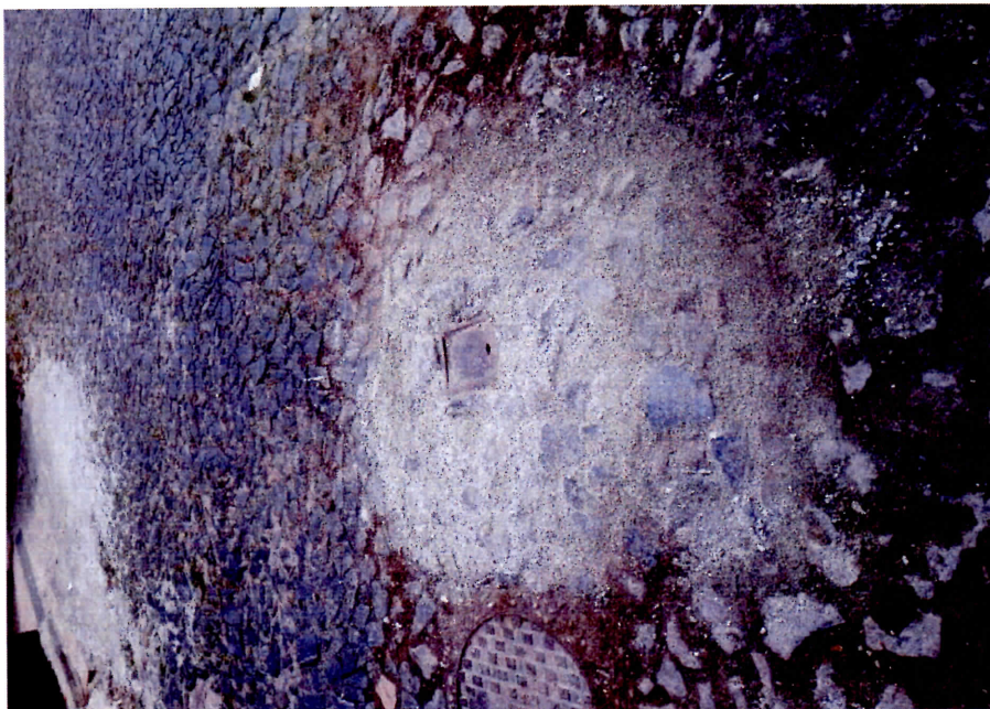
REPARO REDE DE ÁGUA, RUA DR. ORLANDO RAMOS, 120, BAIRRO VILA SÃO JOSÉ (13/05/2022)
