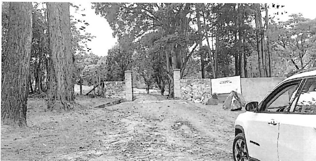
Figura 5 - Acesso provisório ao loteamento a partir da Rodovia dos Inconfidentes.
