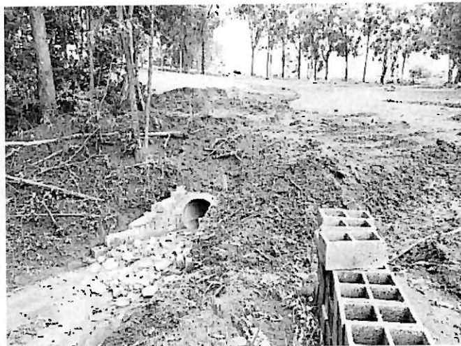
Figura 13 - Detalhe do sistema de drenagem pluvial localizado na Área Verde 8. Vê-se ao fundo o local onde será construída a praça 3.
