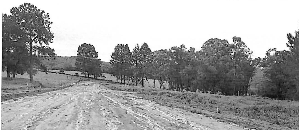
Figura 6 - Rua 14 com praça de retorno ao fundo e acesso a rua 15 à direita. À esquerda vê-se a quadra 27 e à direita, quadras 25 (em primeiro plano) e 26 ao fundo.
