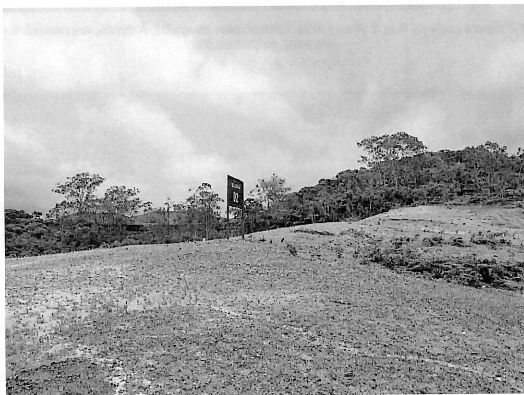
Figura 10 – Vista a partir da Quadra 02. Vê-se trecho da Rodovia Rodrigo Melo Franco de Andrade (BR-356) ao fundo e parte da movimentação de terra da quadra 01.
