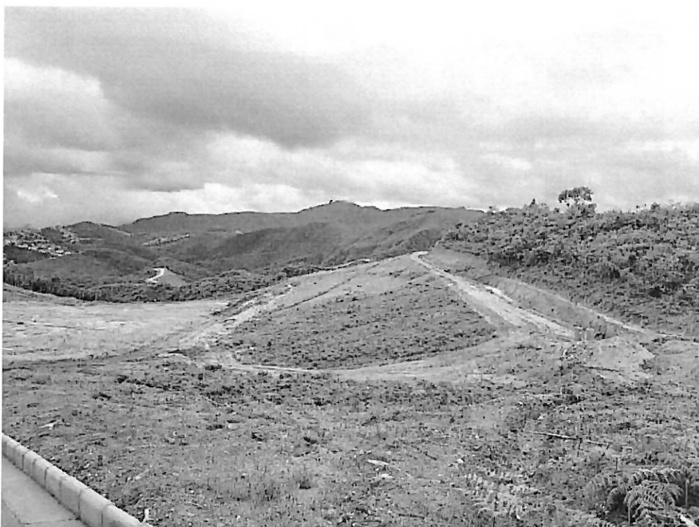
Figura 7 – Vista a partir da Rua 2. À esquerda, continuidade da rua 02. À direita, rua provisória no fundo dos lotes da Quadra 01 .
