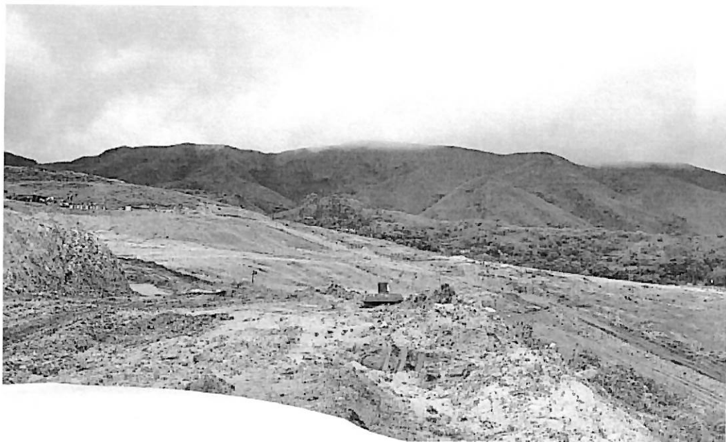
Figura 12 – Vista a partir da rua 02.
