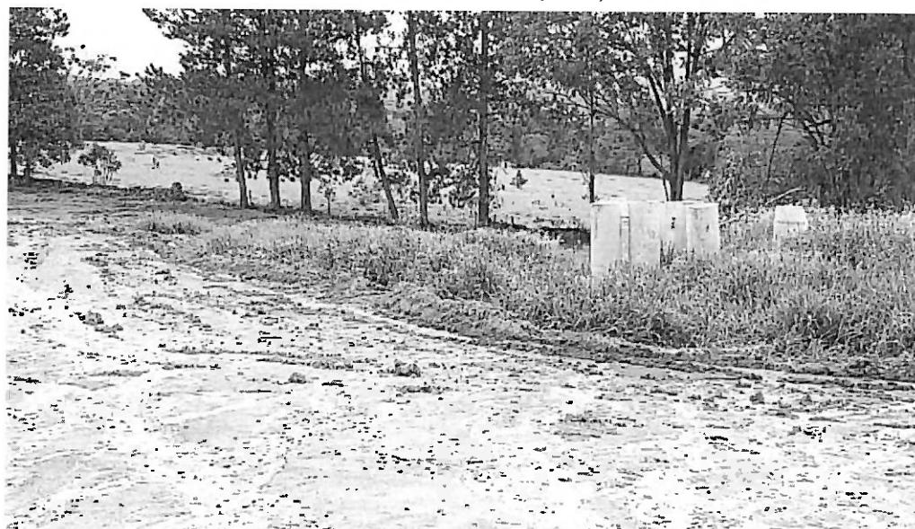
Figura 7 - Detalhe das manilhas utilizadas no sistema de drenagem pluvial, em execução.
