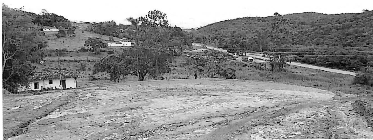
Figura 3 - Vista da praça de retorno e praça 1 (porção oeste) ao final da avenida A com BR356 ao fundo.
