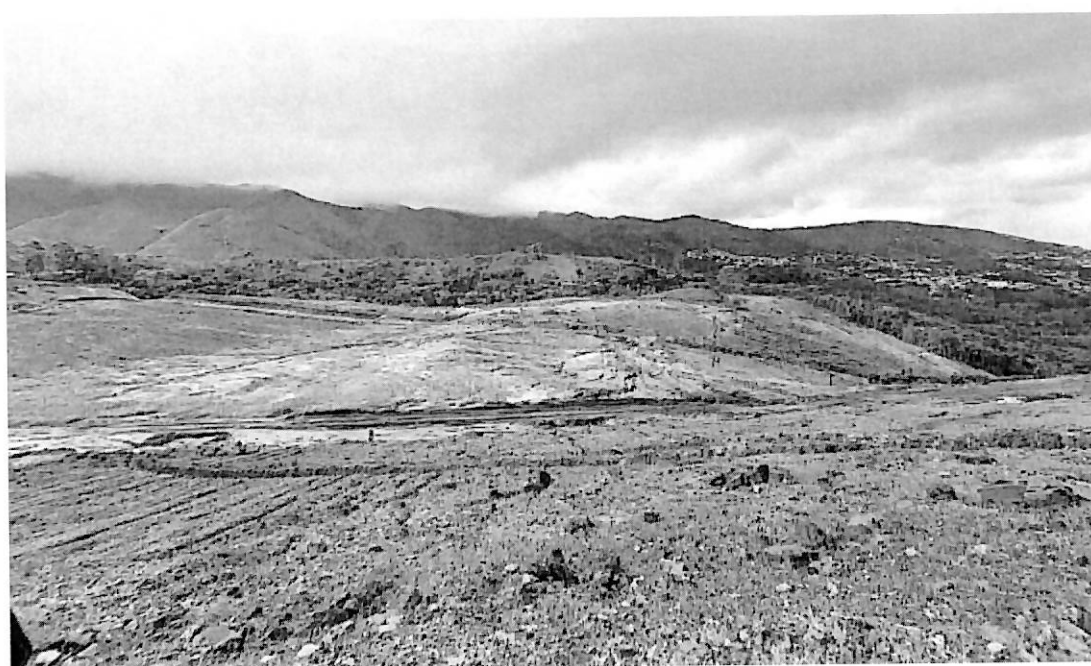
Figura 19 – Detalhe da canaleta provisória construída no interior da quadra 01 para drenagem de águas de chuva.
