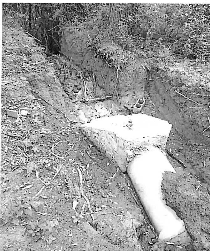
Figura 17 - Detalhe do parte do dissipador de energia do sistema de drenagem.
