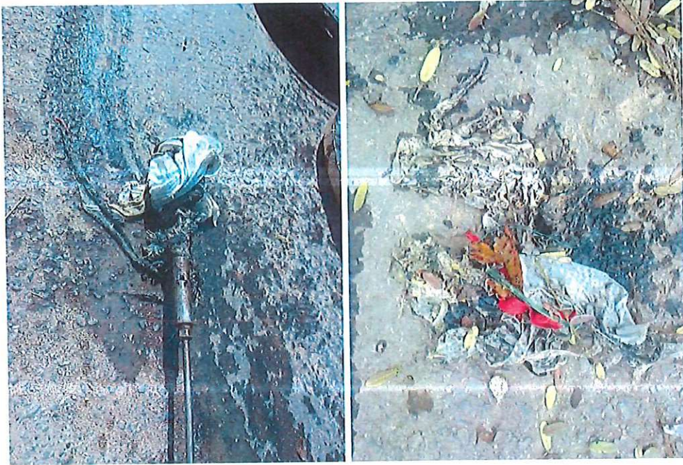
DESOBSTRUÇÃO DE REDE DE ESGOTO, RUA TOMBADOURO, CACHOEIRA DO CAMPO (29/11/2023)
