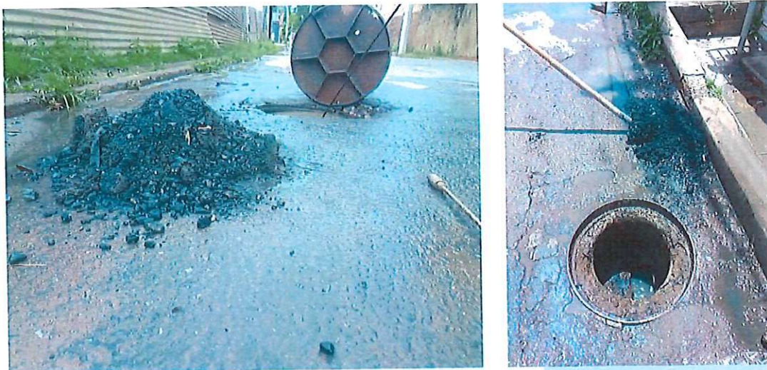
DESOBSTRUÇÃO DE REDE DE ESGOTO, RUA TOMBADOURO, CACHOEIRA DO CAMPO (29/11/2023)
