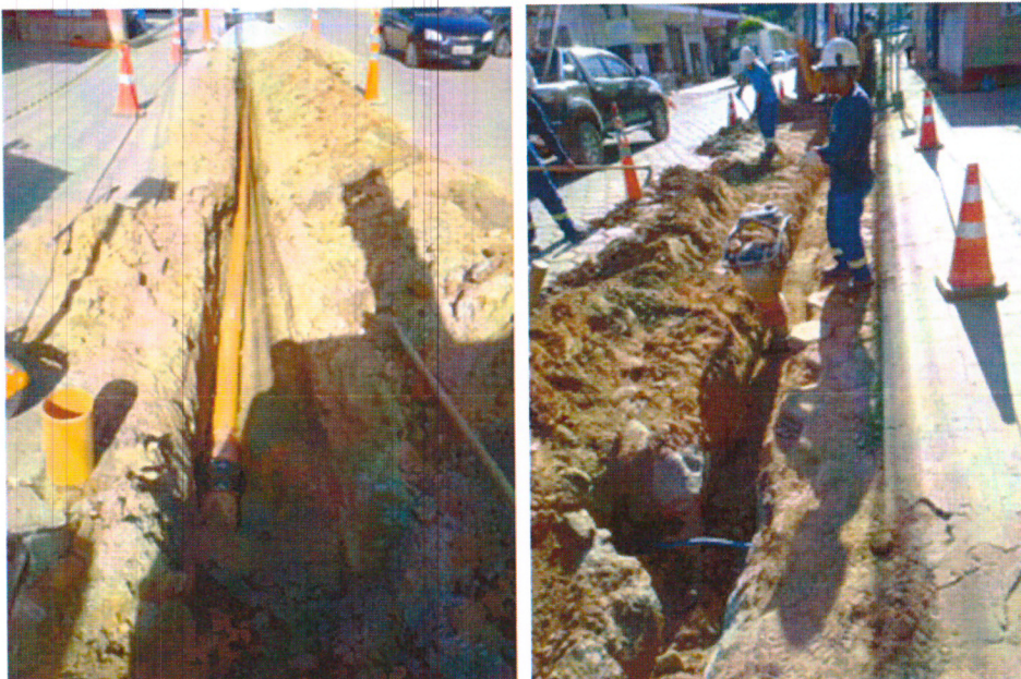
REPARO REDE DE ESGOTO, RUA PADRE PEDROSA, AMARANTINA, PROTOCOLO Nº 3039775 (16/05/2024)
