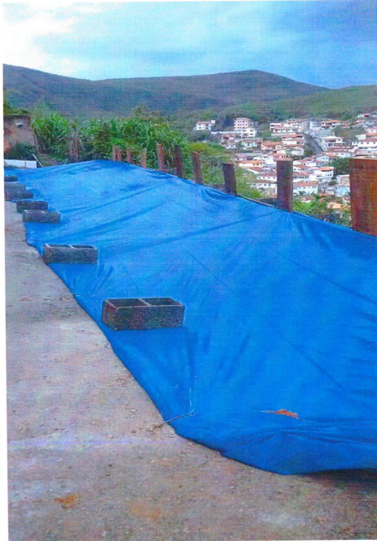
*IMAGEM 2. COLOCAÇÃO DE LONA PARA MINIMIZAÇÃO DE IMPACTOS DE INFILTRAÇÃO PLUVIAL À RUA OLARIA, BAIRRO CABEÇAS*
