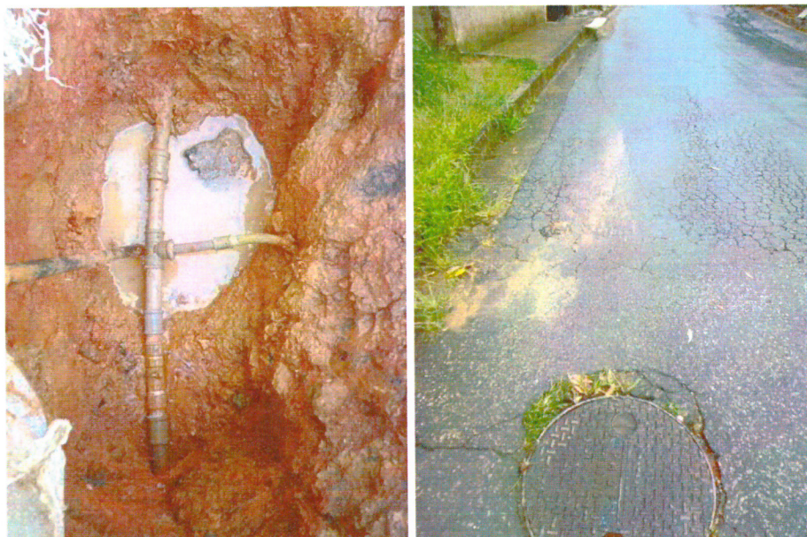
REPARO DE VAZAMENTO EM REDE DE ABASTECIMENTO À RUA HUM, BAIRRO ALTO DO BELEZA (27/01/2025)
