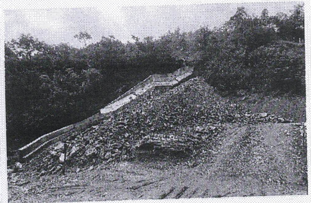
Fotos 1 – demonstra a travessia executada e liberada e Foto 2 – demonstra o muro defletor executado para a passagem de água que possa verter pelo vertedouro
