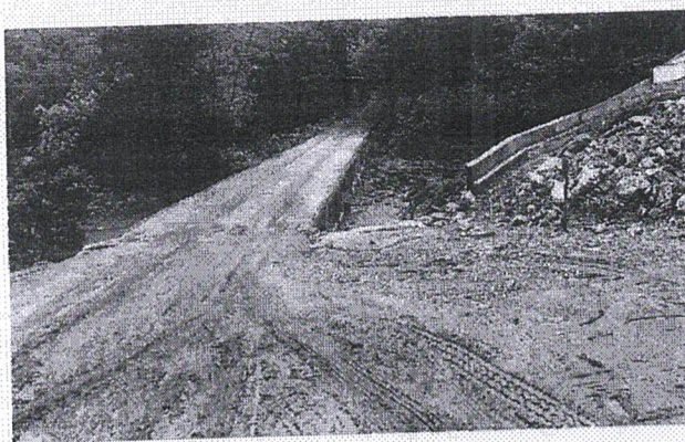
Fotos 1 – demonstra a travessia executada e liberada e Foto 2 – demonstra o muro defletor executado para a passagem de água que possa verter pelo vertedouro
