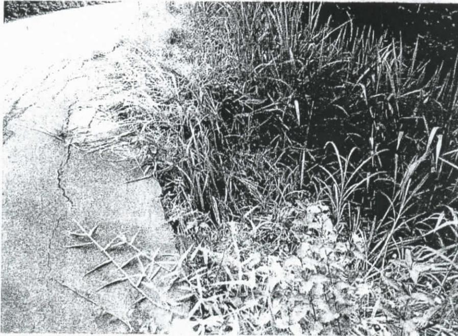
Figura 6 – Vista da pavimentação danificada.
