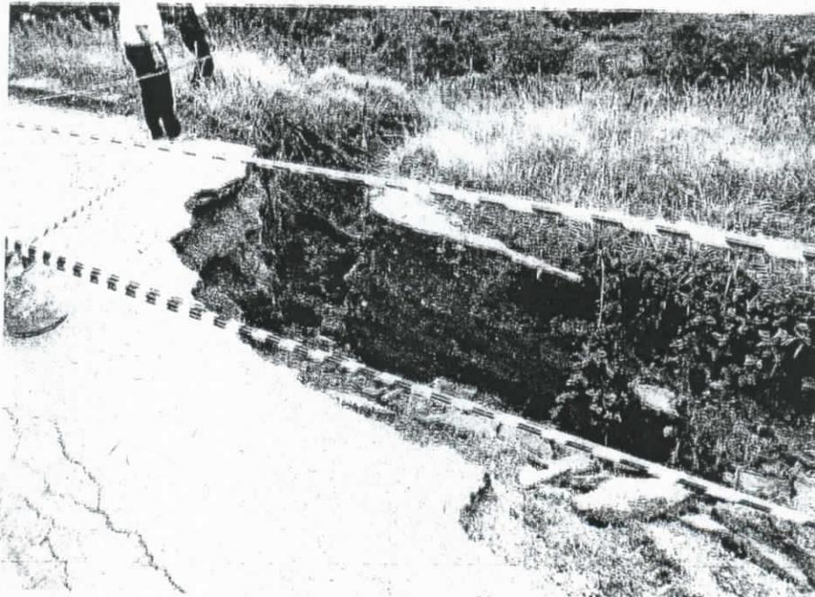
Figura 3 – Vista da pavimentação danificada.
