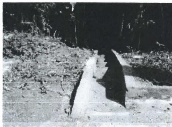
FOTO 14: Escada hidráulica próxima à obra/4
