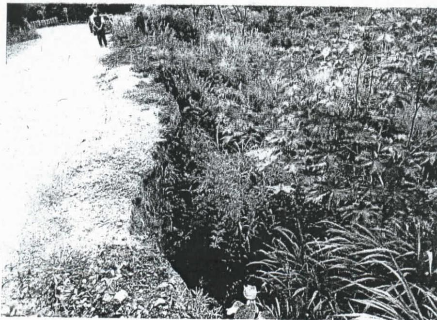
Figura 9 – Vista da pavimentação danificada.
