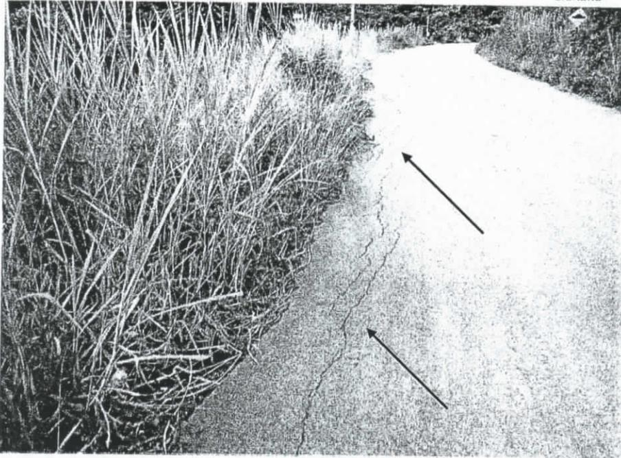
Figura 2 – Trinca na pavimentação indicando movimentação e comprometimento do mesmo.
