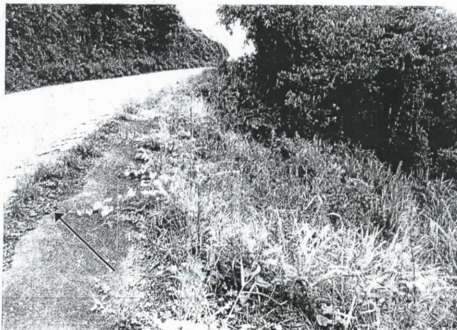
Figura 5 – Vista da pavimentação danificada. Detalhe da barreira colocada para impedimento da água.
