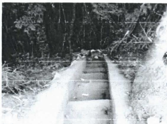
FOTO 22: Escada hidráulica próxima à obra/ 7
