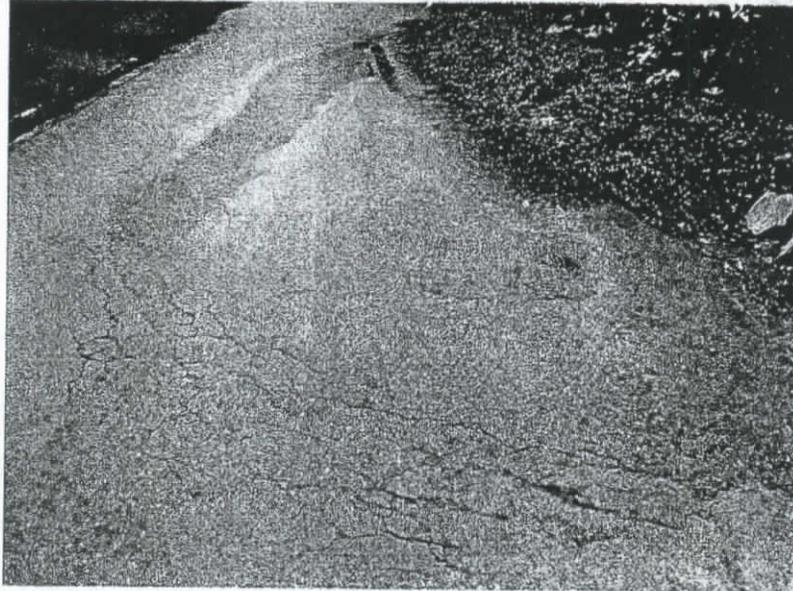
Figura 2 – Trincas na pavimentação indicando movimentação e comprometimento da mesma. Acesso a Glaura e São Bartolomeu.
