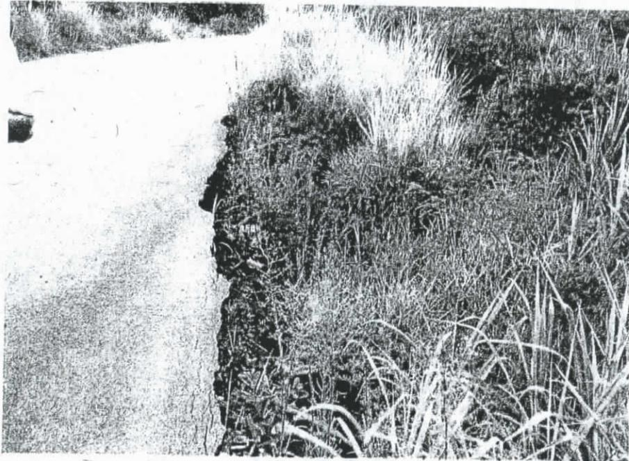
Figura 1 – Vista da pavimentação danificada.
