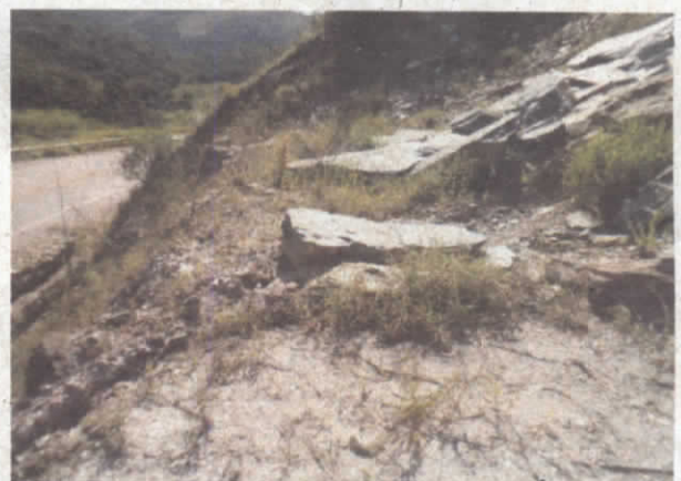
Foto 06: Rochas fragmentadas e acomodadas na banqueta do talude (vista de cima).
