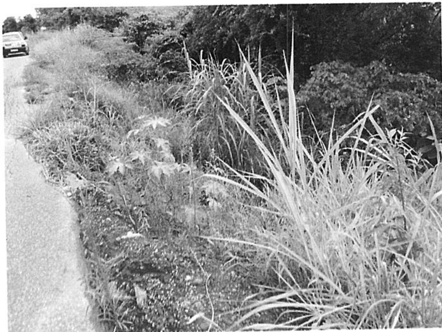
Figura 4 – Vista da pavimentação danificada.
