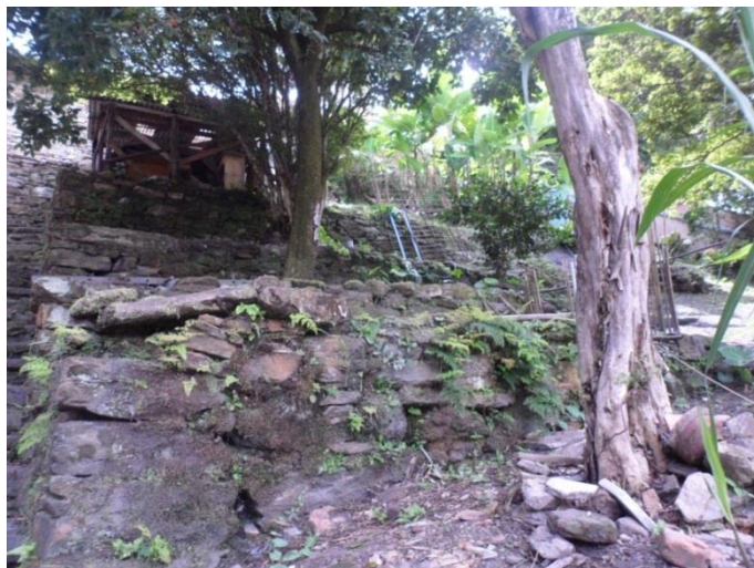
Foto 3 - Área 1 - Perfis de escalonamento com contenções em muro de pedra seca. Autora da foto - Érika Gomes.
