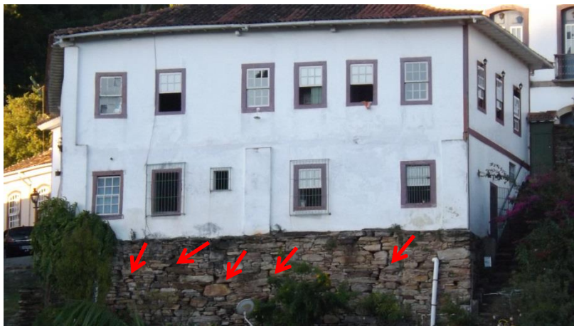
Foto 37 - Possível desalinhamento de pedras em face de muro de contenção. Autora da foto - Érika Gomes.
