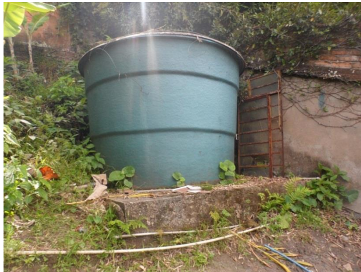
Foto 12 - Área 1 – Exemplo de sobrecarga sobre o terreno. Autora da foto - Érika Gomes.
