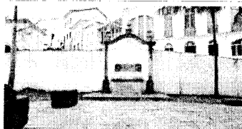
17 – Chafariz do Pilar / Praça Américo Lopes - Pilar
