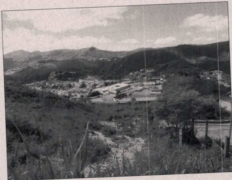
Foto 4.1- Vista geral da encosta localizada a leste do pátio da escola (seta). Notar a alta declividade e forma côncava da encosta, bem como os afloramentos de filito.
