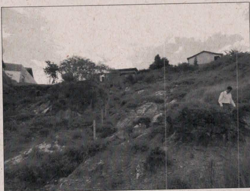
Figura 1.5 – Vista para o talvegue onde pode-se notar a evolução dos processos erosivos acompanhado por processos de deslocamentos “empastilhamento” do maciço de filito condicionado pelo plano da foliação.
