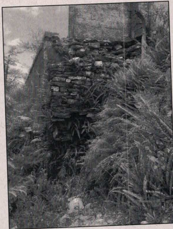
Foto 5.4- Vista geral para o muro de gravidade constituído por blocos tabulares de quartzito descalçado na base por provável ruptura planar envolvendo o aterro da escola.
