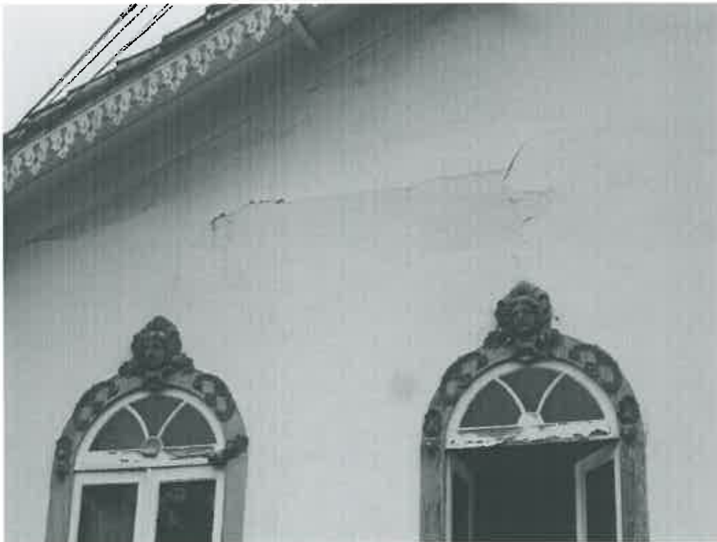
2.2.1 – VISÃO DETALHADA FRONTAL DE UM PONTO CRÍTICO QUE O REBOCO DO PRÉDIO ESTÁ EM RISCO EMITENTE DE QUEDA.
