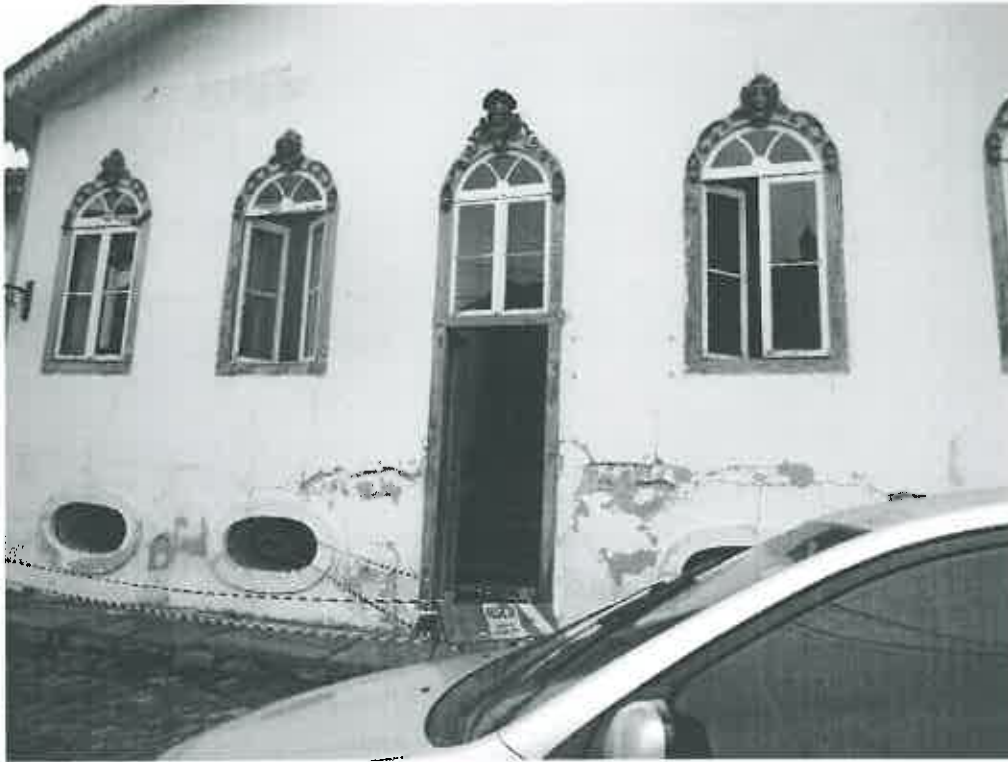
2.2.1 – VISÃO DETALHADA FRONTAL DE UM PONTO CRÍTICO QUE O REBOCO DO PRÉDIO ESTÁ EM RISCO EMITENTE DE QUEDA.
