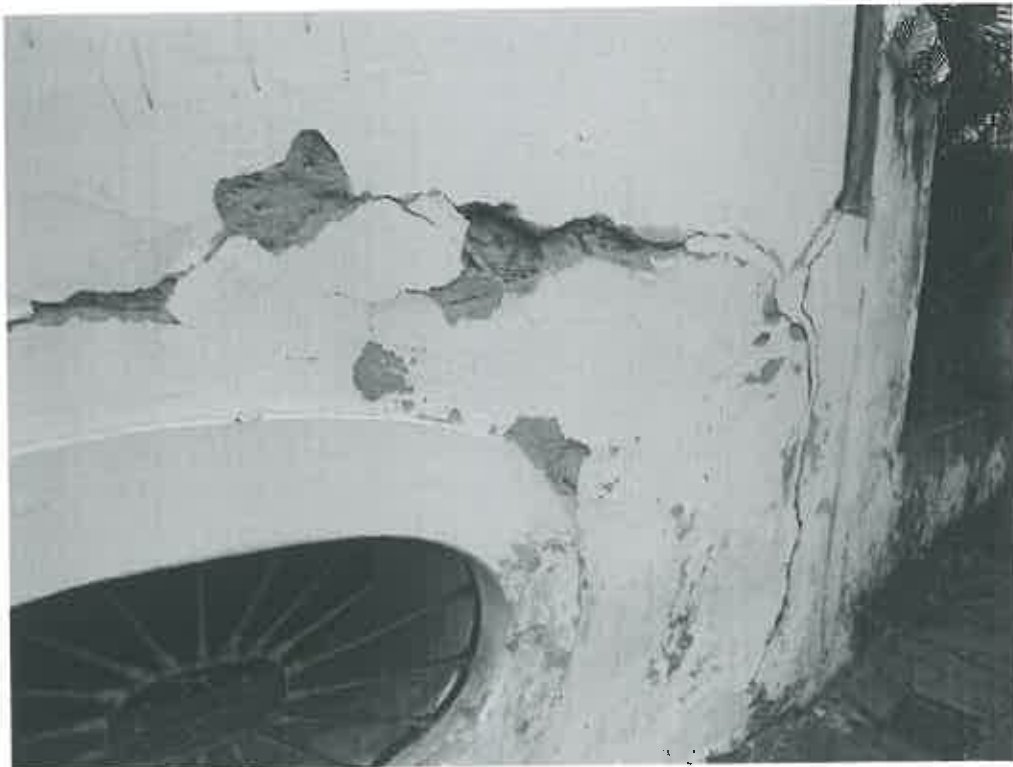
2.4 – PARTE BAIXA PRÓXIMO A CALÇADA (PASSEIO) QUE APRESENTA RACHADURAS E REBOCO SOLTO.
