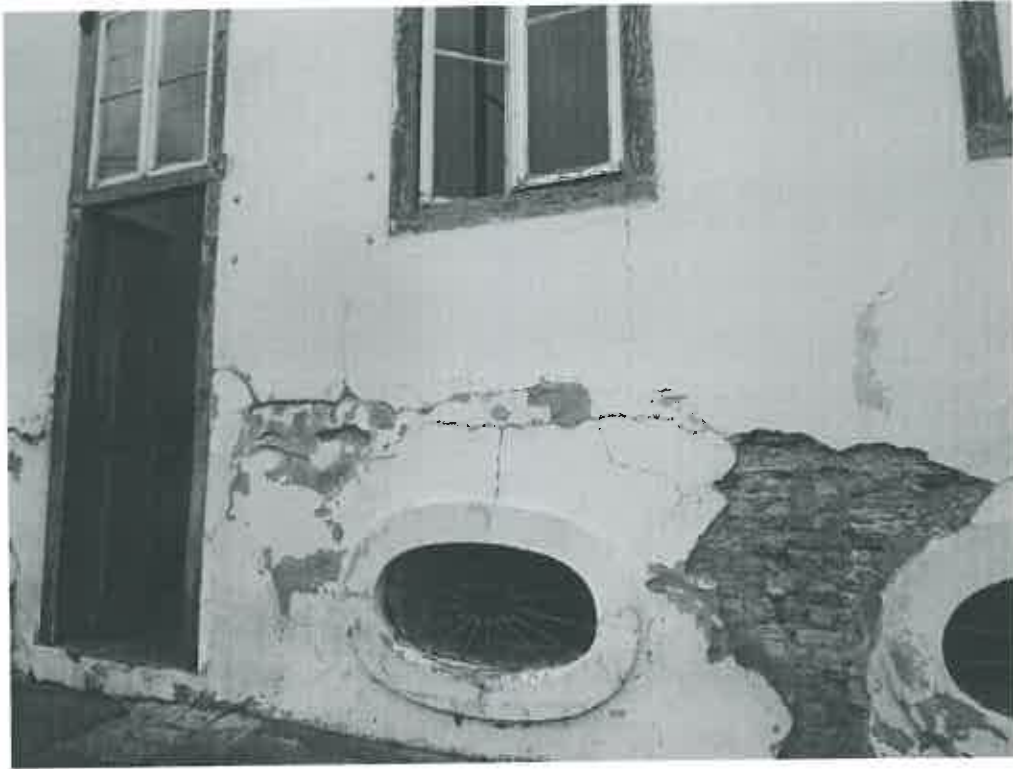
2.4 – PARTE BAIXA PRÓXIMO A CALÇADA (PASSEIO) QUE APRESENTA RACHADURAS E REBOCO SOLTO.
