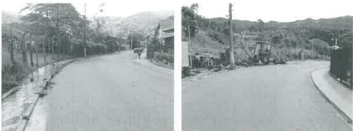
Fotos 03 e 04: Vista ampla do trecho e visualização da ausência de dispositivos de drenagem.
