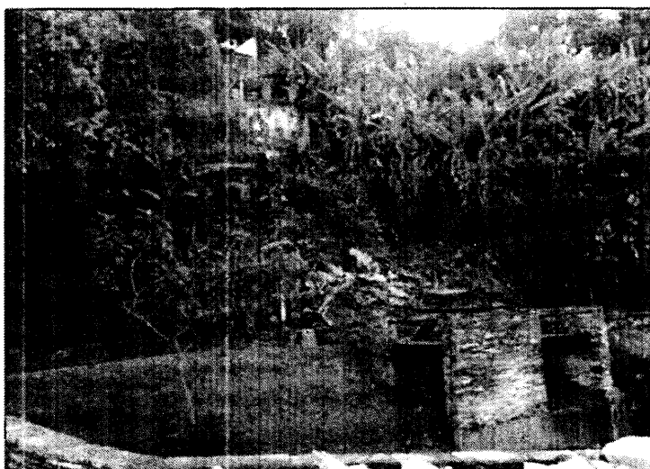
Foto 5 – Vista geral para a porção da encosta situada no setor B. Notar a elevada declividade.
