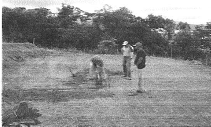
Obras de abertura das fundações para construção das unidades habitacionais
