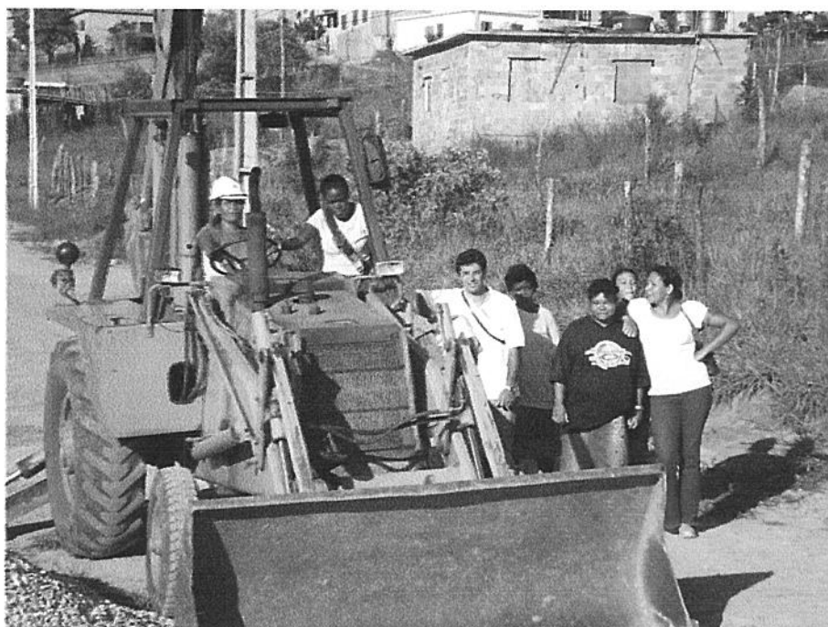
visita da equipe de fiscalização (formada por moradores removidos do Alto Taquaral) ao canteiro de obras (foto 02)
