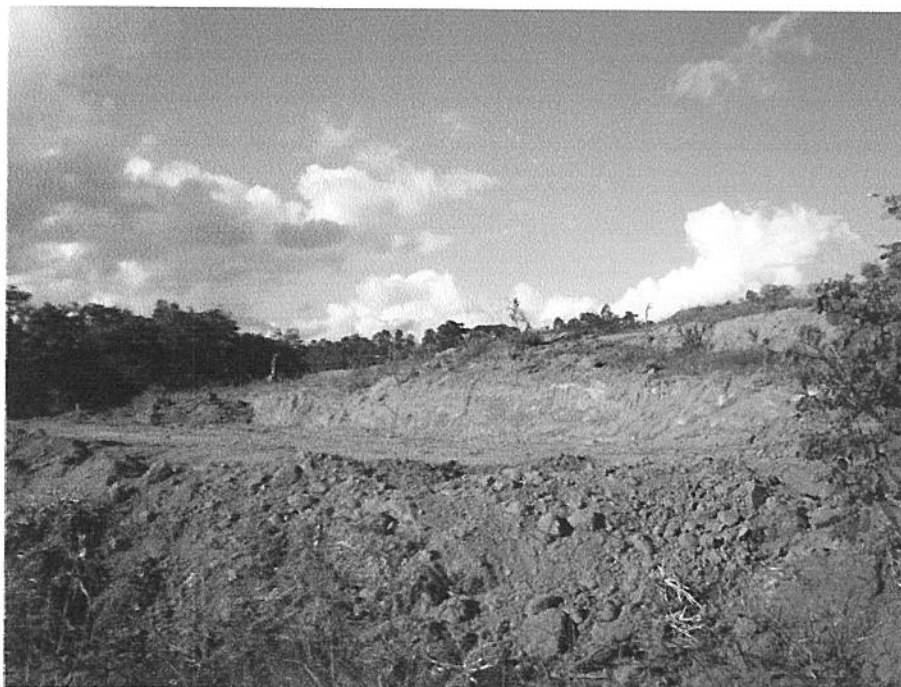
Vista dos lotes terraplanados para início das edificações das unidades habitacionais
