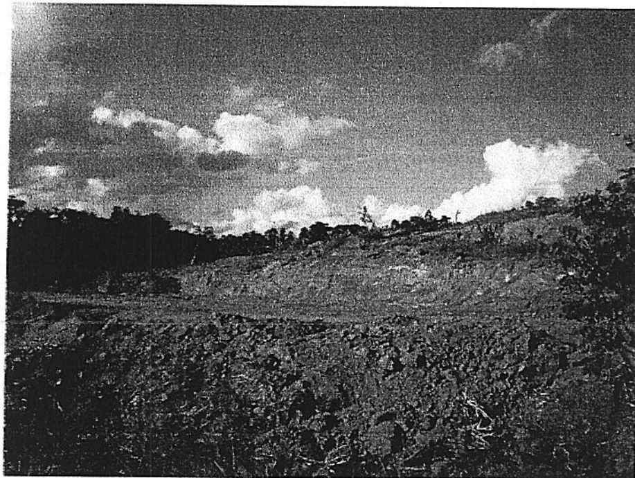
Vista dos lotes terraplanados para início das edificações das unidades habitacionais
