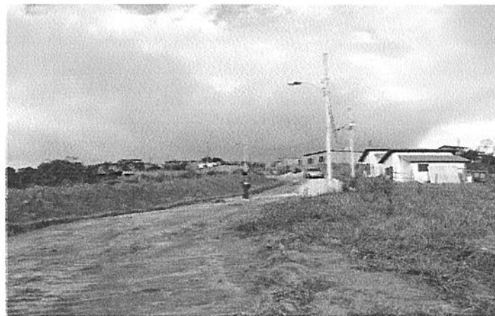
Abertura das redes de esgotamento sanitário e drenagem pluvial
