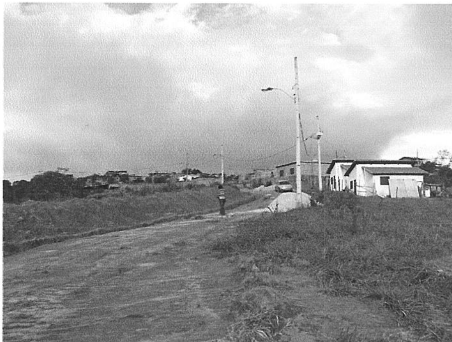
Vista da abertura das valas para rede de esgotamento sanitário e drenagem pluvial (foto 01)
