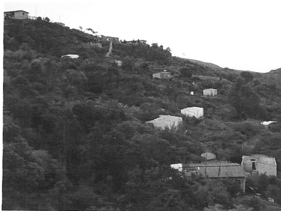
Vista geral da área (destaque para demolição de residências de famílias já removidas)
