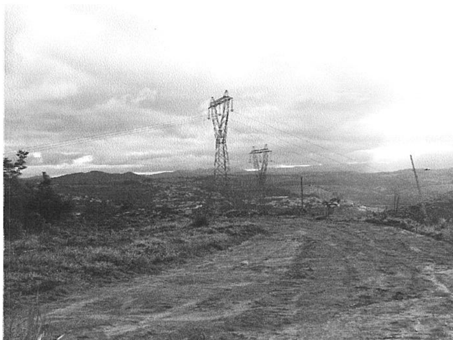
vista parcial das ruas em processo de terraplanagem (foto 02)
