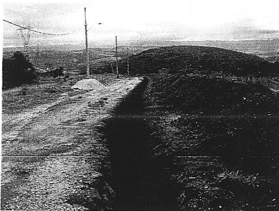
Vista da abertura das valas para rede de esgotamento sanitário e drenagem pluvial (foto 02)
