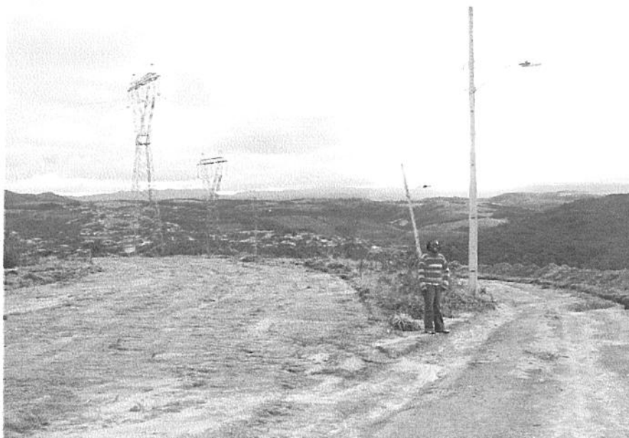
vista parcial das ruas em processo de terraplanagem (foto 01)
