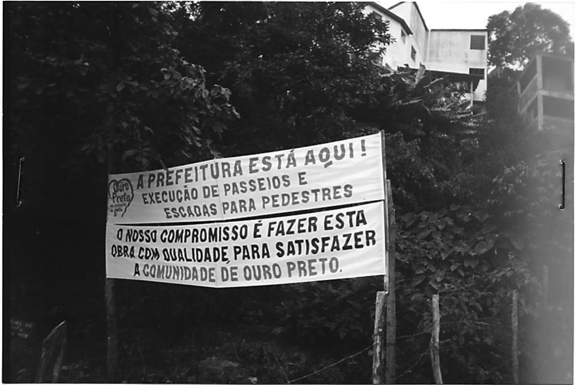
(Placa indicativa da obra)
