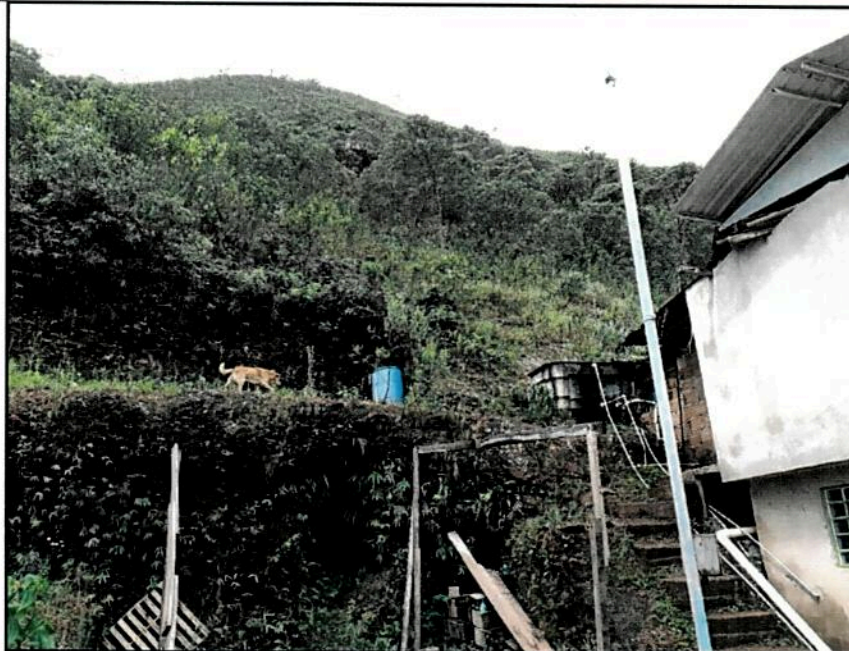
Figura 4 – Visão da encosta após o primeiro e discreto movimento de massa planar ocorrido no dia 05/01/2018, quando uma pequena placa se deslocou e se apoiou sobre um aqueduto do Século XVIII. Autor: Charles Romazâmu Murta. Local: Rua Pirita, Bairro São Cristóvão; Data: 05/01/2018.
