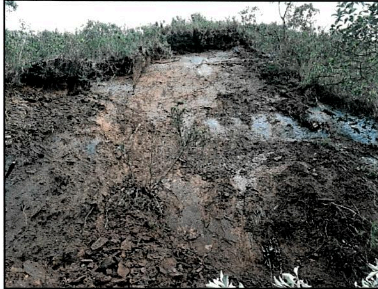
Figura 6 Visão a partir do aqueduto para montante da cicatriz do último movimento planar ocorrido por volta das 02h:00min. do dia 06/01/2018. Note que o deslocamento foi condicionado às duas famílias de fraturas frontais e laterais na imagem mostrada. Autor: Charles Romazâmu Murta. Local: Rua Pirita, Bairro São Cristóvão; Data: 06/01/2018.
