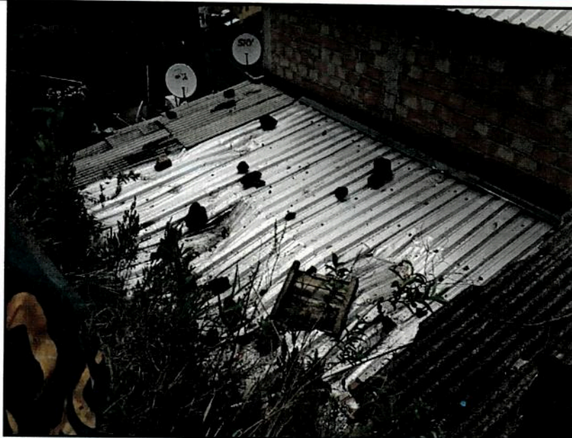
Figura 14 – Visão do telhado de metalão sobre os quartos da residência do Sr. João Gualberto Cândido onde a família dormia após ter sido atingido pelos blocos de canga durante o movimento de massa planar. Note que o telhado se deformou e absorveu o impacto impedindo assim que a laje fosse atingida. Autor: Charles Romazâmu Murta. Local: Rua Pirita, Bairro São Cristóvão; Data: 06/01/2018.
