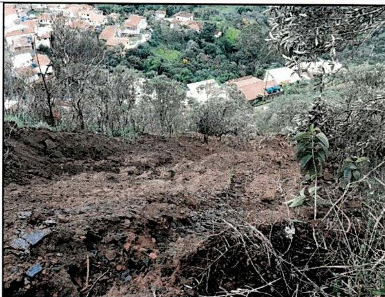
Figura 8 – Visão para jusante do movimento de massa planar a partir do aqueduto. Note que houve uma deflexão para a esquerda na rota do deslizamento ao longo da encosta. Autor: Charles Romazâmu Murta. Local: Rua Pirita, Bairro São Cristóvão; Data: 06/01/2018.
