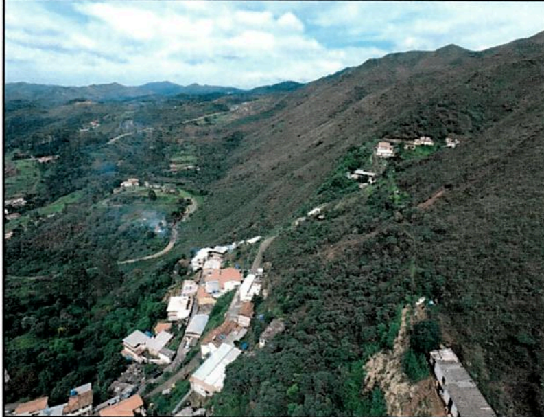
Figura 2 – Visão geral para Oeste do flanco da Serra de Ouro Preto enfatizando o alto ângulo de mergulho da foliação do Itabirito, o local do deslizamento e as residências em situação de risco geotécnico alto à jusante. Autor: Charles Romazâmu Murta. Local: Rua Pirita, Bairro São Cristóvão; Data: 13/01/2018.
