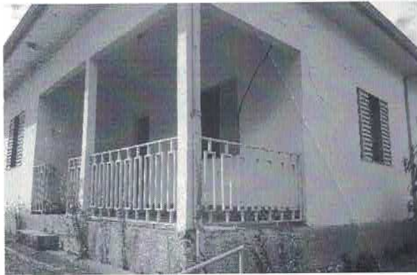
FIGURA 1: Parte frontal da edificação
