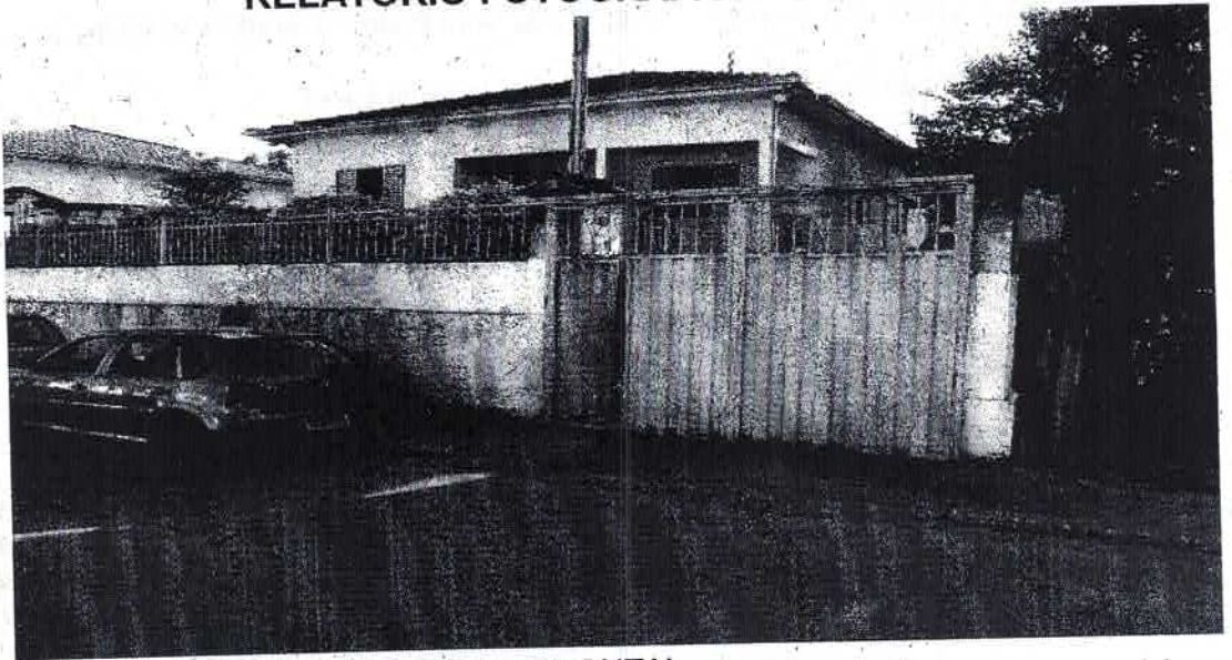
FOTO Nº 1 - VISTA DA FACHADA FRONTAL
