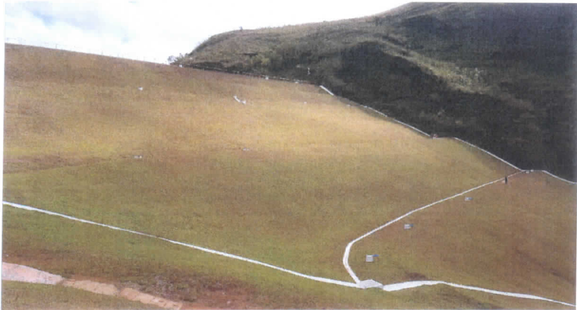
Foto 02 – Aspecto geral do talude de jusante no dia 24/07/2017.
