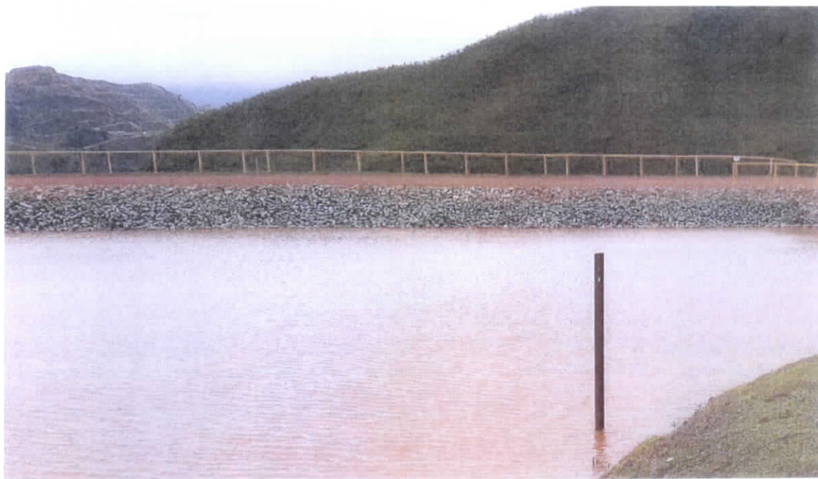
Foto 04 – Aspecto geral do talude de montante (“rip-rap”) no dia 24/07/2017.
