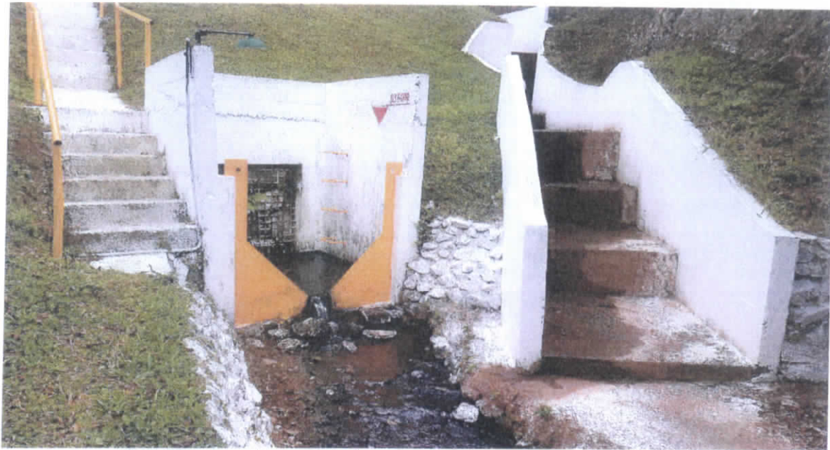
Foto 03 – Aspecto geral da área do pé da barragem no dia 24/07/2017.
