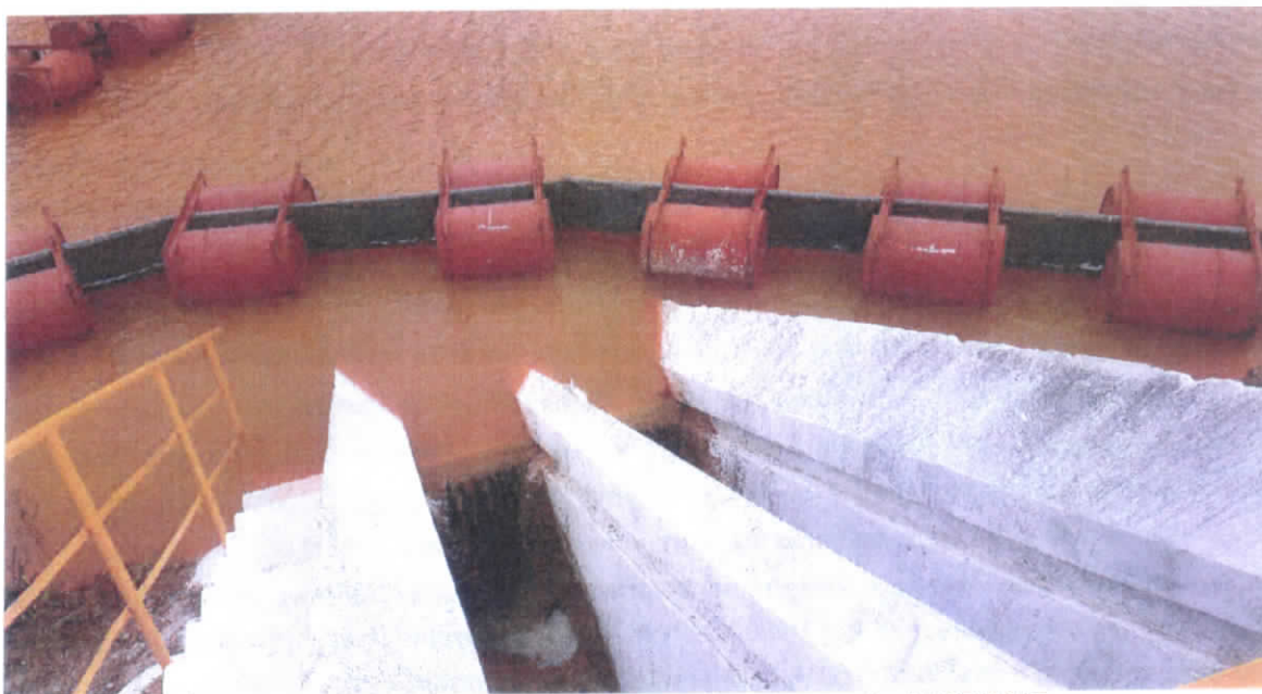
Foto 06 – Aspecto geral do sistema extravasor no dia 24/07/2017.
