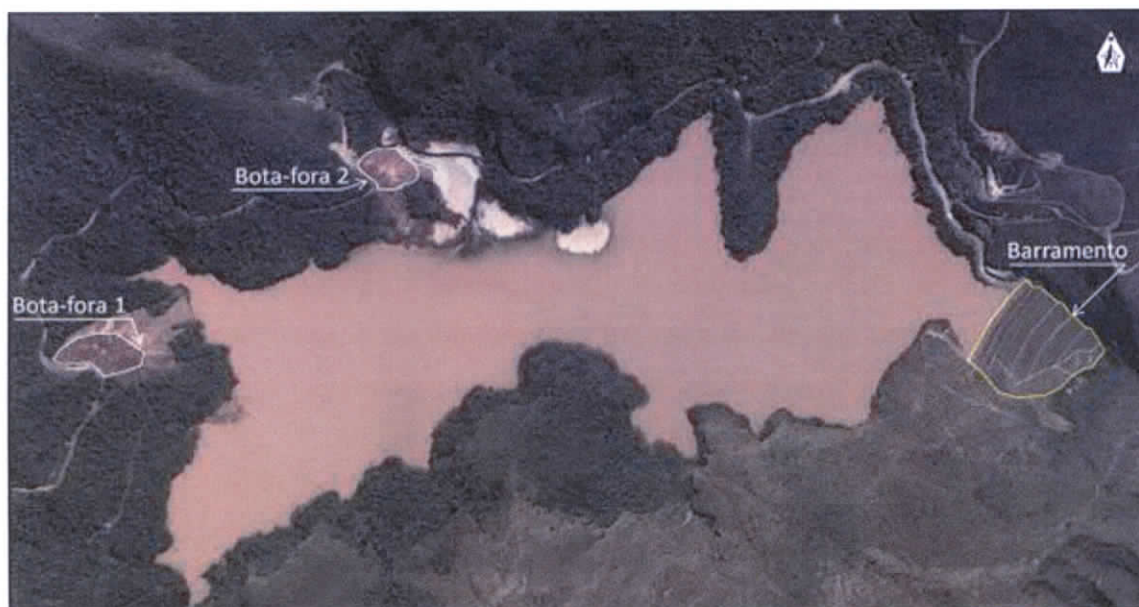
Figura 1 - Vista geral da Barragem do Marzagão, com indicação das pilhas de bota-fora (Fonte: Google Earth)
