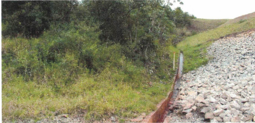
Figura 4.5 – Vista da ombreira direita, com destaque para canaleta de drenagem periférica.
