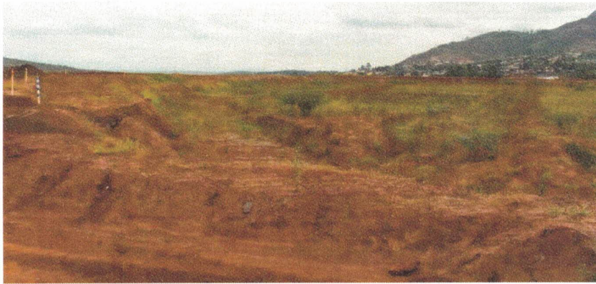
Figura 4.3 – Vista geral do talude de montante.
