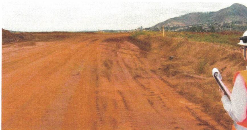
Figura 4.1 – Vista do Coroamento da barragem Auxiliar do Vigia.
