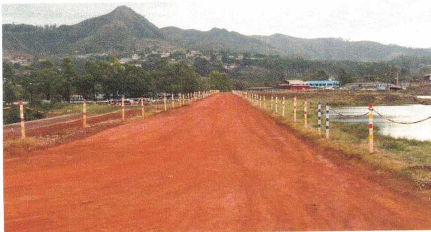
Figura 4.1 – Vista do Coroamento
