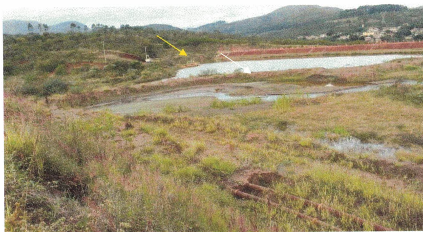
Figura 4.8 – Reservatório da barragem do Vigia. A seta amarela indica sistema de bombas instalado no reservatório e a seta branca indica baia para auxiliar na clarificação do efluente e decantação dos sedimentos.
