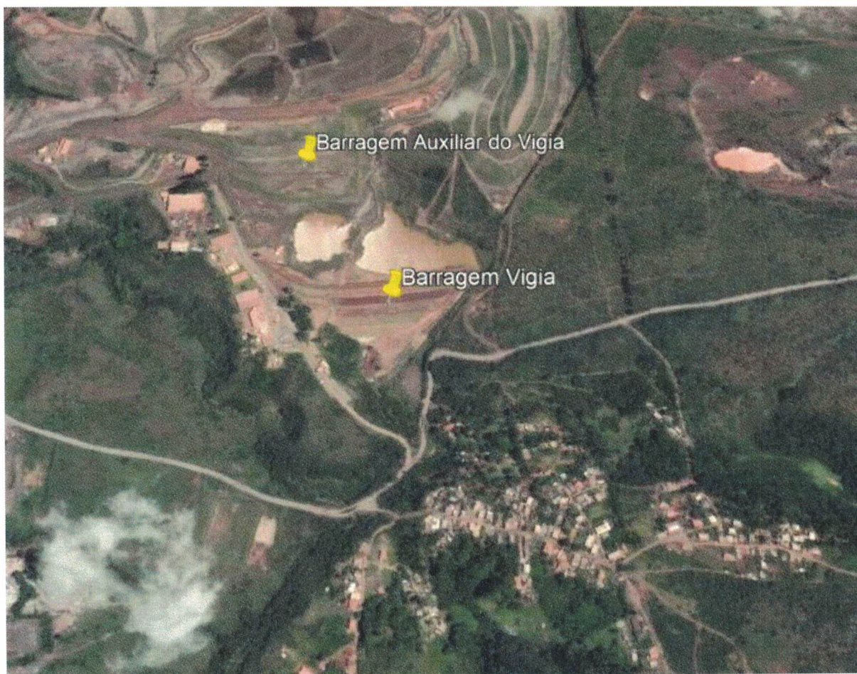
Figura 3.3 – Imagem área com a localização das barragens do Complexo Pires. Fonte: (Google Earth, 2018)
