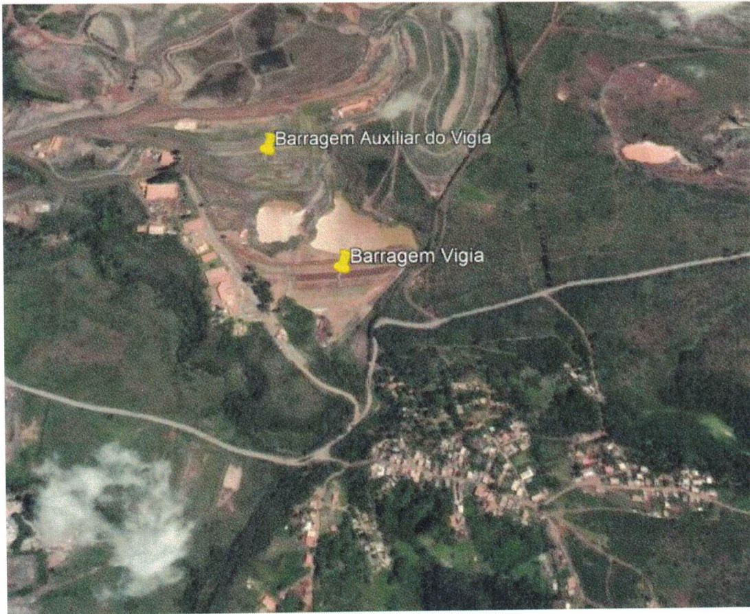
Figura 3.3 – Imagem área com a localização das barragens do Complexo Pires. Fonte: (Google Earth, 2018)
