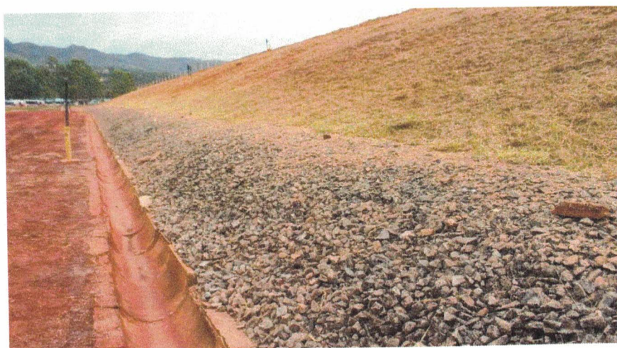
Figura 4.13 – Dispositivos de drenagem interna
