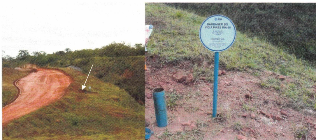
Figura 4.7 – Em (A) vista da ombreira esquerda com seta indicando a localização da surgência relatada em auditorias anteriores. Em (B) a ausência de surgência evidenciada no dia, e a presença de instrumento de monitoramento.
