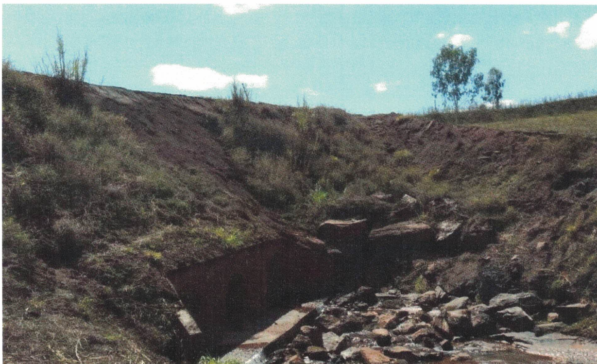
Figura 4.10 – Desemboque do sistema extravasor (bueiro triplo).
