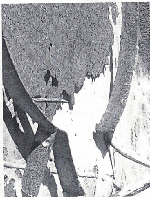
FOTO 02 – Tampa do reservatório
