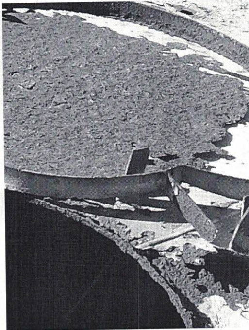
FOTO 03 – Teto do reservatório
