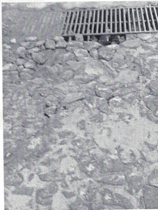
FOTO 01 – CALÇAMENTO E BUEIRO DE DRENAGEM PLUVIAL
