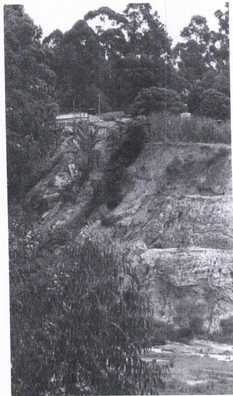
Figura 3 – Talude erodido com entulhos e residência contígua.
