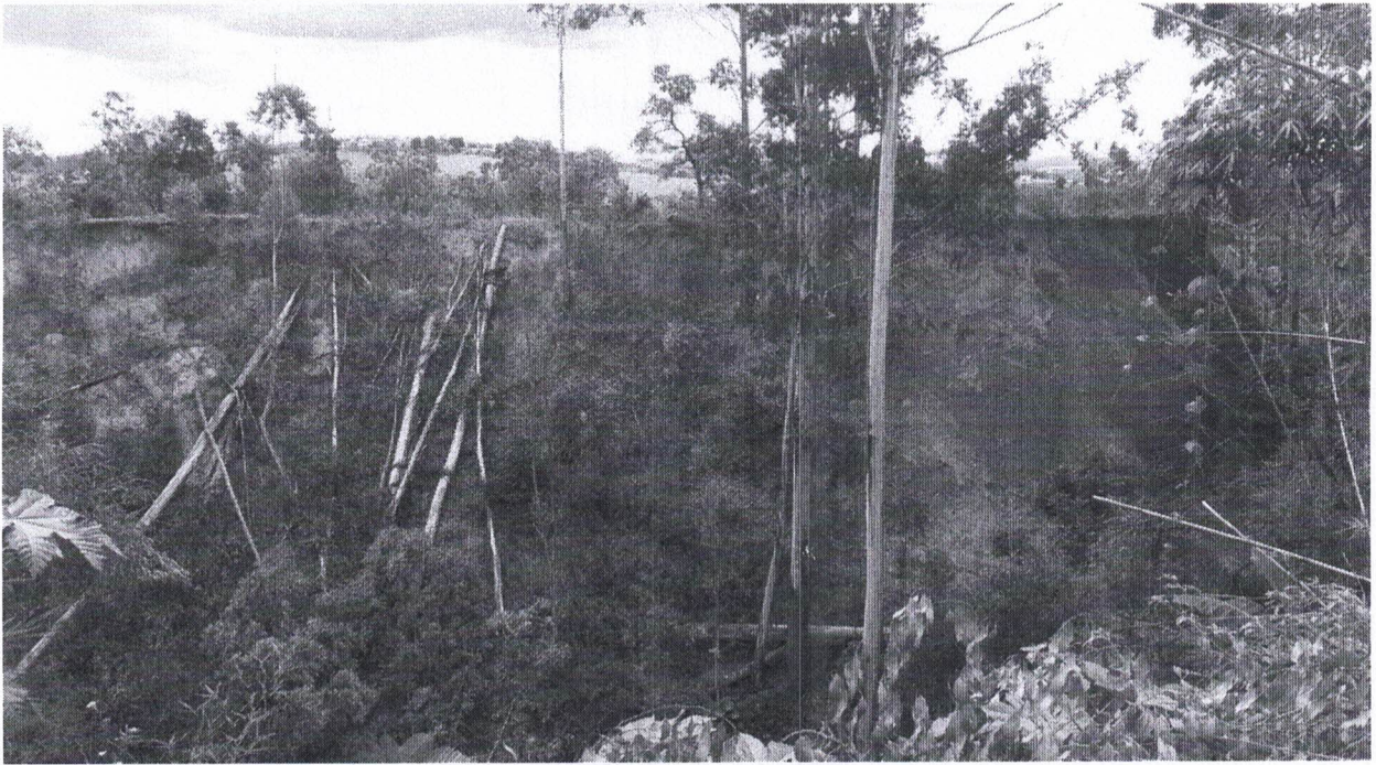
Figura 5 – detalhe de talude erodido - Rua 2
