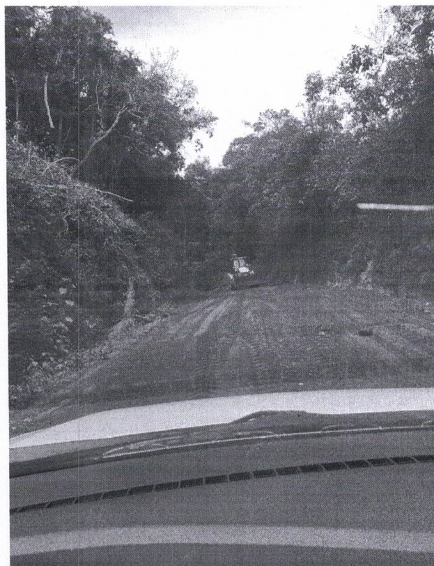
Figura 3: Fiscalização de Obra - Sapecado
