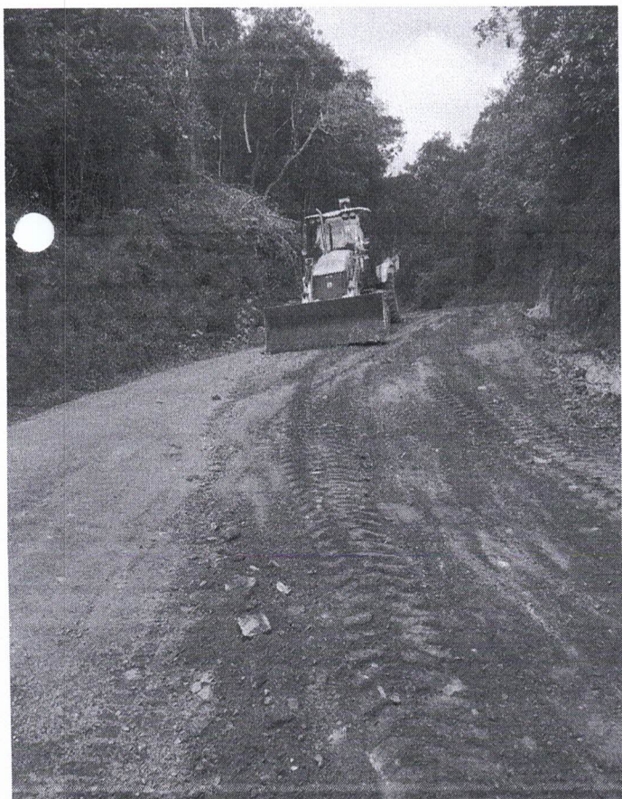
Figura 4: Fiscalização de Obra - Sapecado
