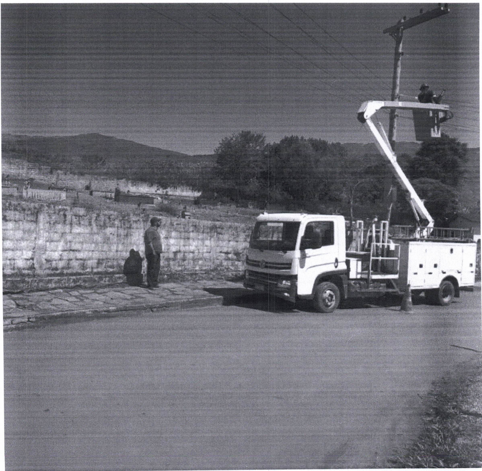
Fiscalização Extensão de Rede elétrica Rua Grande Queimada (Rua do cemitério Antenor Pereira)
