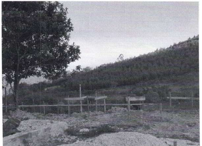
Figura 2: Fiscalização de Obra no Subdistrito Serra dos Cardosos
