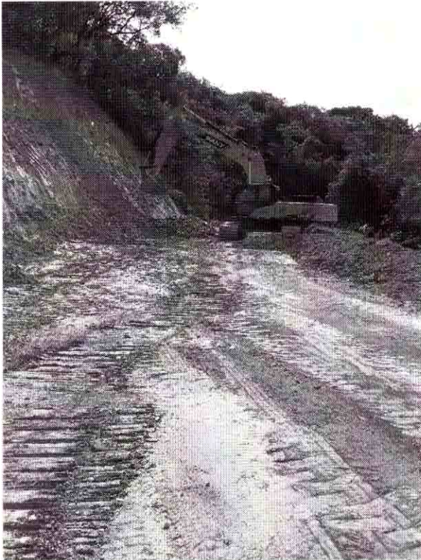
Figura 7: Visita à Localidade Bandeiras para fiscalização de serviço em execução no local.
