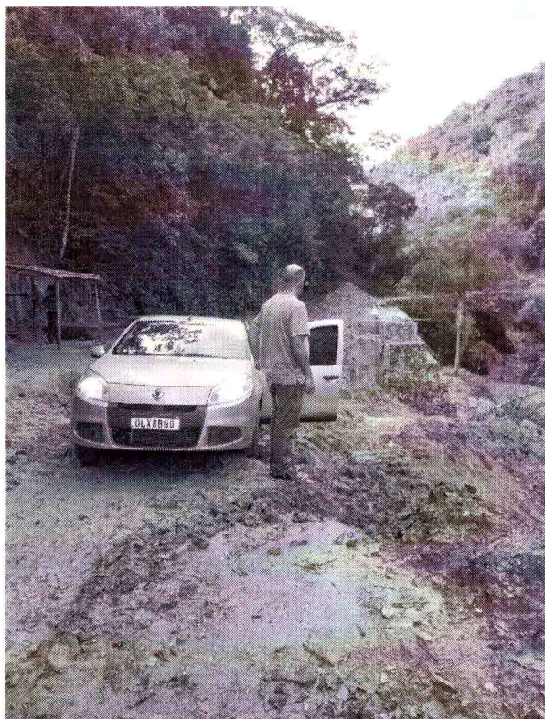
09-01-2023 - Visita à ponte dos tabuões para vistoria de serviço em execução no local.
