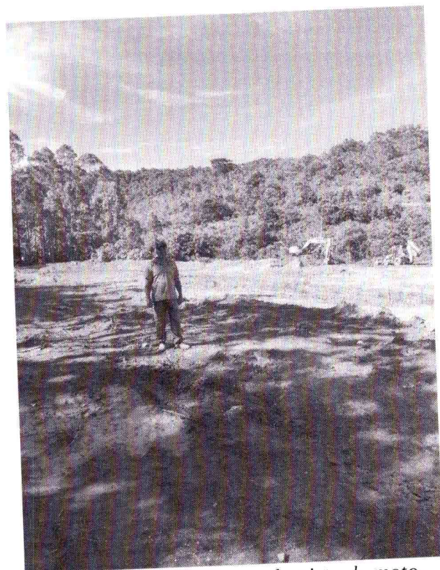
13/03/2023 - Visita à obra da pista de motocross no distrito de Santa Rita
