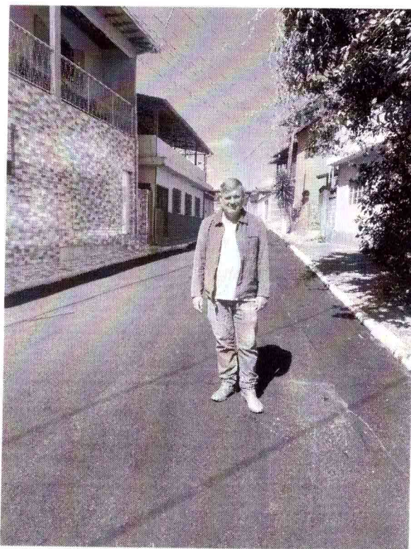
19/05/2023 - Rua Pedra Sabão (Santa Rita) - Fiscalização de serviço executado no local.
