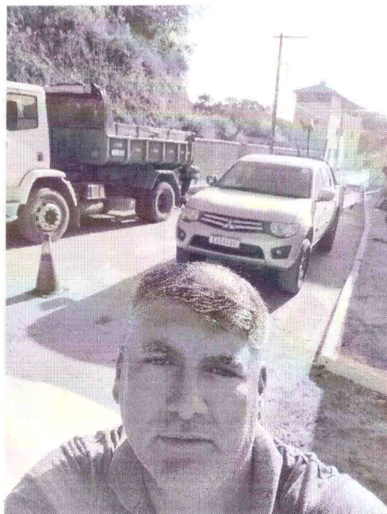
12/05/23 – Rua Júlio Fortes (Santa Rita) Fiscalização de serviço em execução no local.
