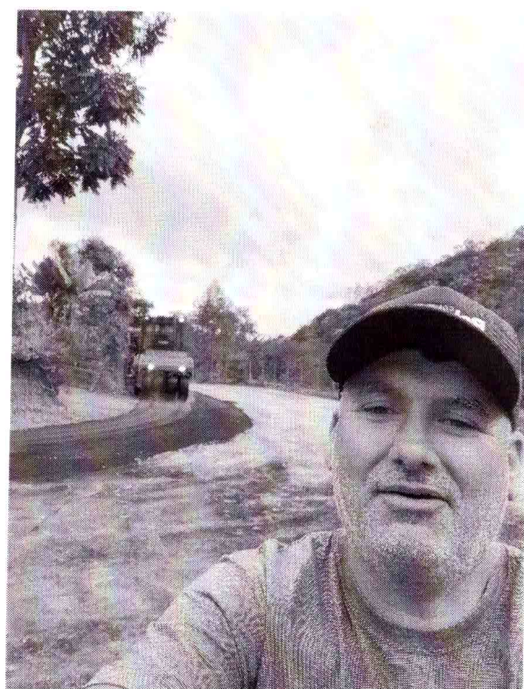
26/05/2023 - Santo Antônio - Fiscalização de serviço em execução no local.
