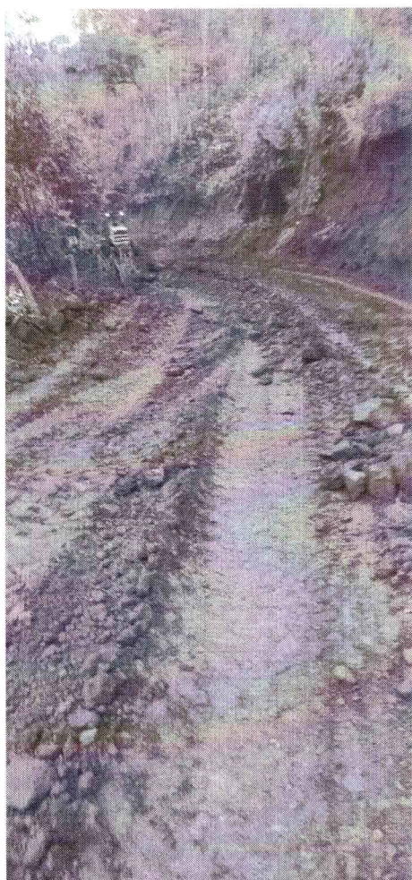
18/08/2023 - Piedade - visita ao Subdistrito para fiscalização de execução de patrolamento na estrada que dá acesso ao local.
