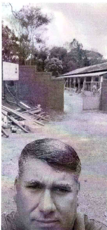
11/09 - Fiscalização de obra em execução na escola do Subdistrito Piedade.
