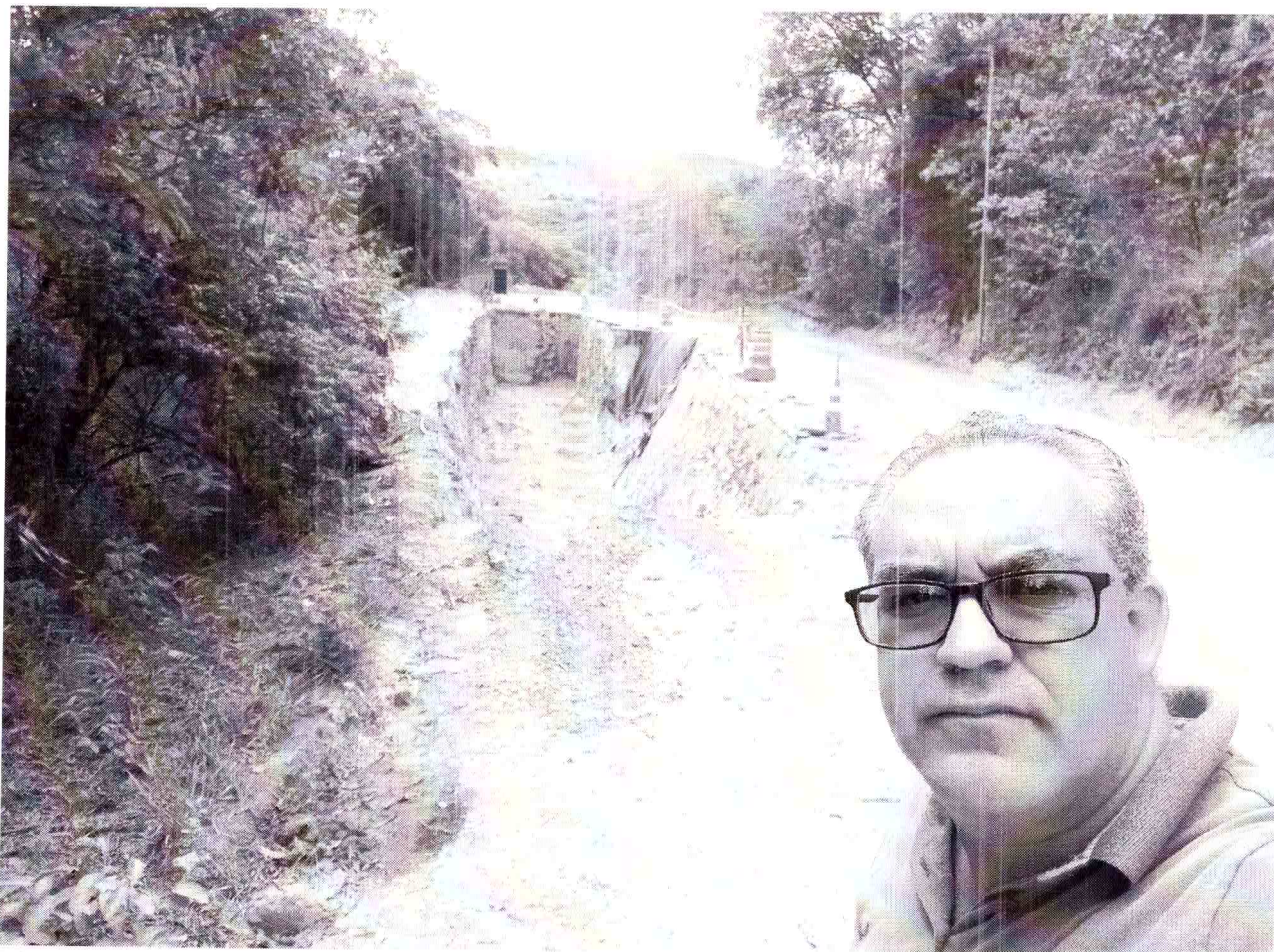
Visita na estrada do distrito de Rodrigo Silva. Data: 23/10/2023
