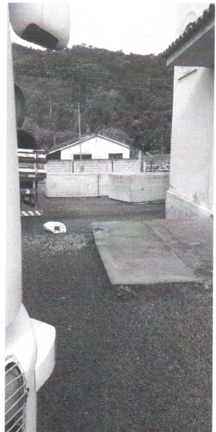
29/01/2024 - Visita ao subdistrito Pasto Limpo para fiscalização de chegada de materiais para construção de pontes no local.
