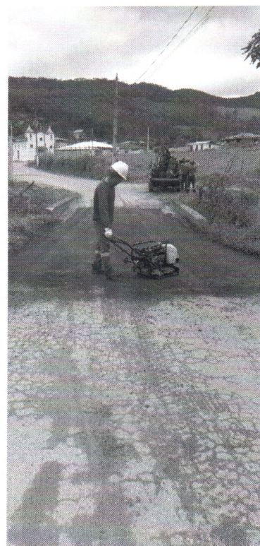
11/01/2024 - Visita ao subdistrito Pasto Limpo para fiscalização de operação tapa buracos em execução no local.
